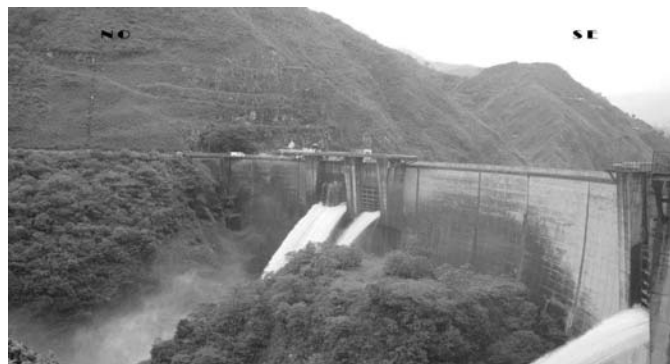
Figura 2. Presa de Arco del Complejo Hidroeléctrico José Antonio Páez
