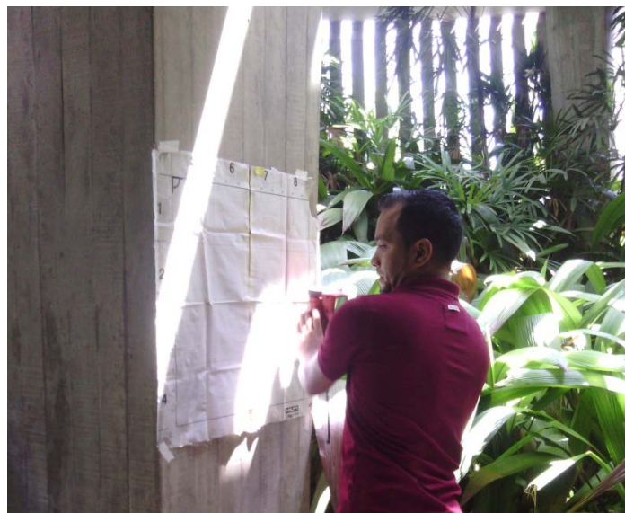
Figura IV.2.1: Medición de columnas con el Ferroscan.
