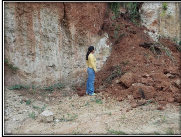
Figura.4.13. Derrumbe en la parte trasera de una vivienda en el sector La Unión.
