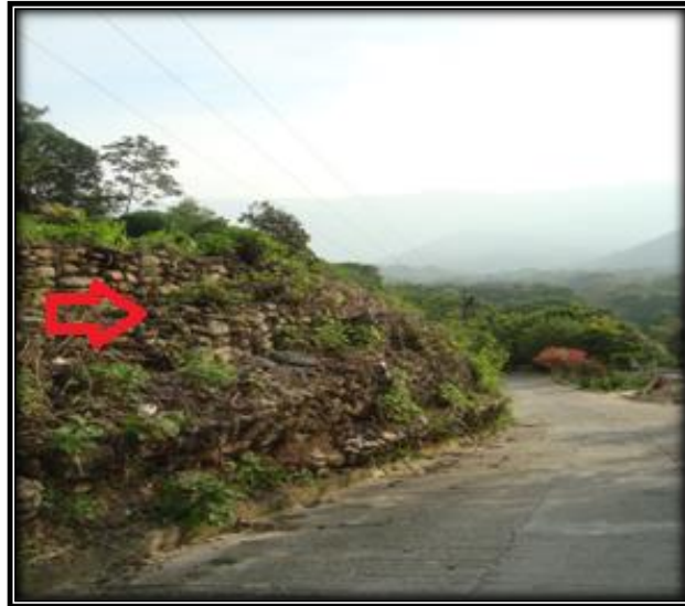
Figura.4.15. La flecha indica el empuje del material. En el sector Las Terrazas
