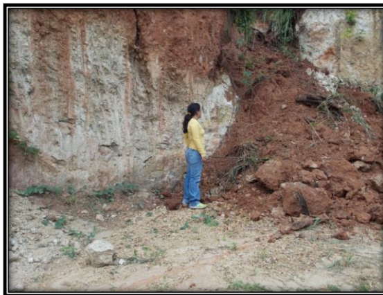
Figura 2.7. Coluvión en el sector Los Caracoles. Las Trincheras
