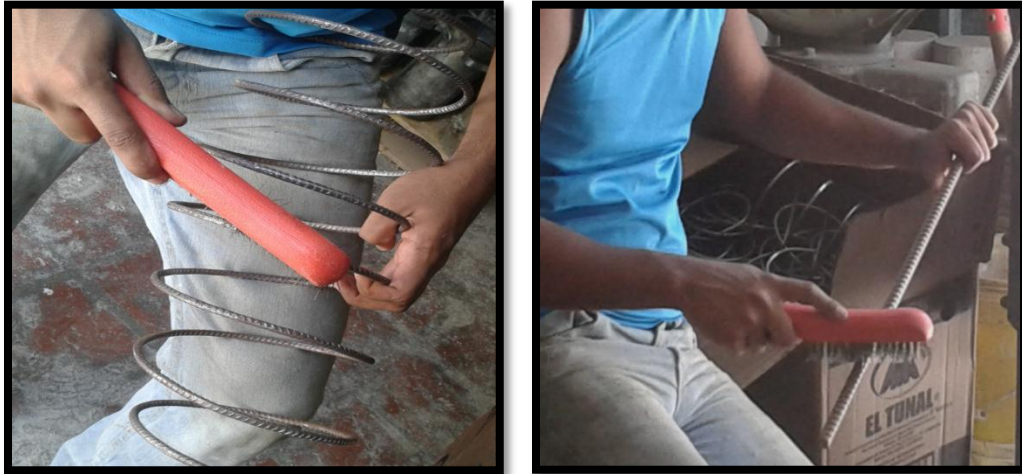
Figura 3.26 Limpieza de las barras.
