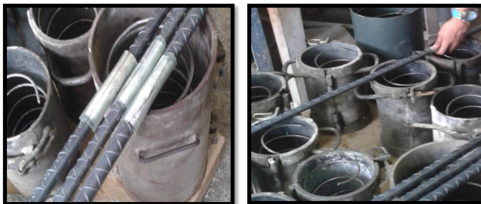
Figura 3.24 Colocación de las mangueras y zunchos.
