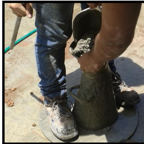
Figura 3.9 Vaciado del concreto.
