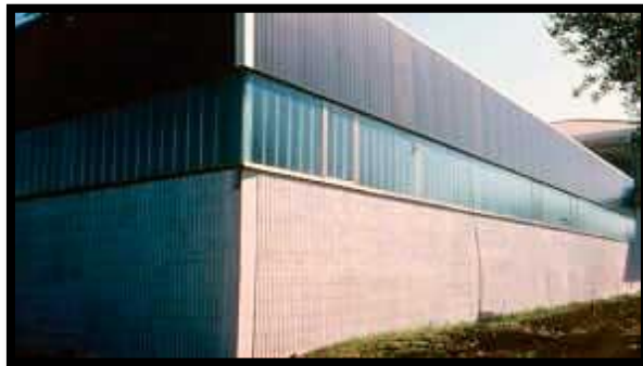
Figura 2.11 Paneles livianos aislante. Fuente: Folleto Agregados Livianos C.A (2012).
