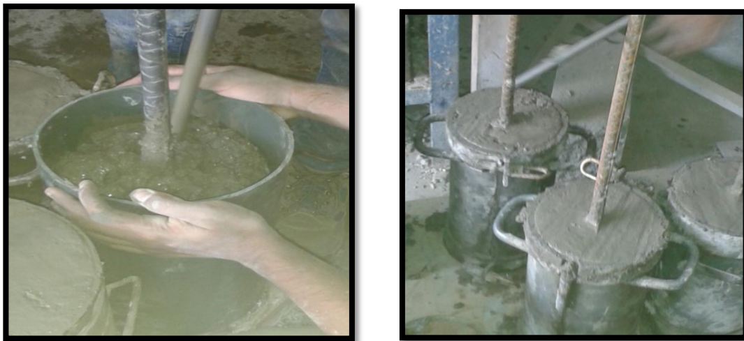
Figura 3. 29 Compactación del concreto.
