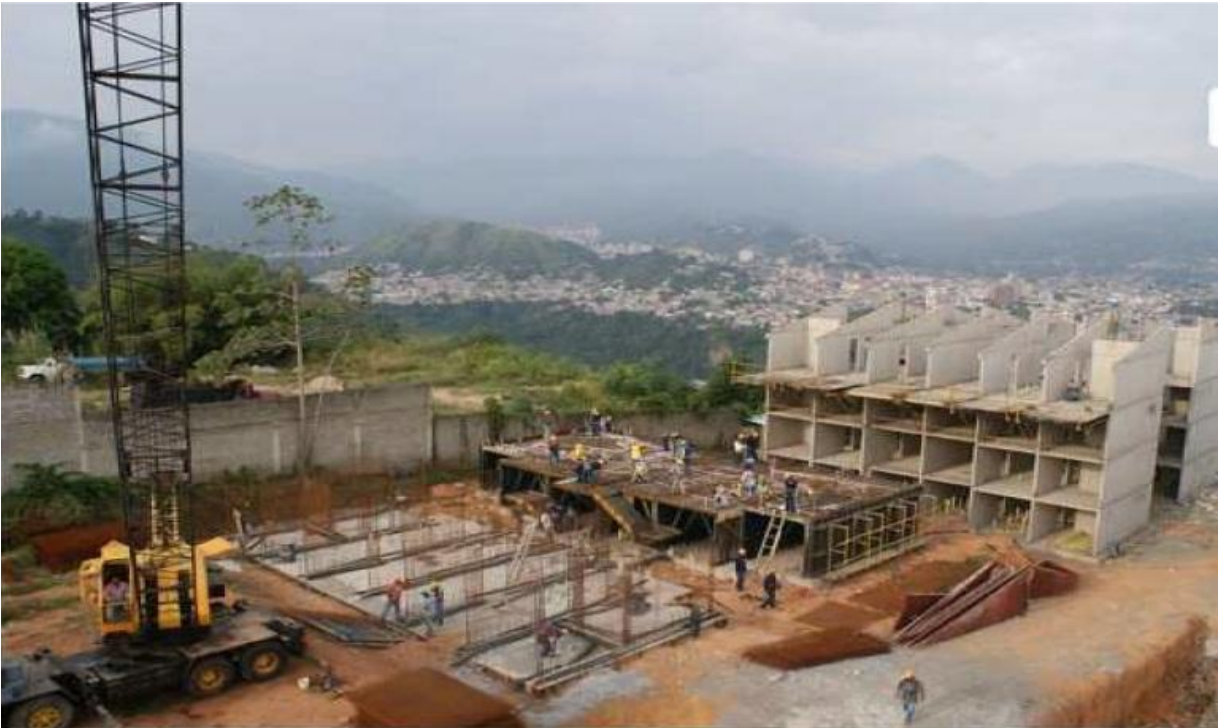
Figura II. 12: Desencofrado mediante una pluma, Fuente Sparthaco Haack
