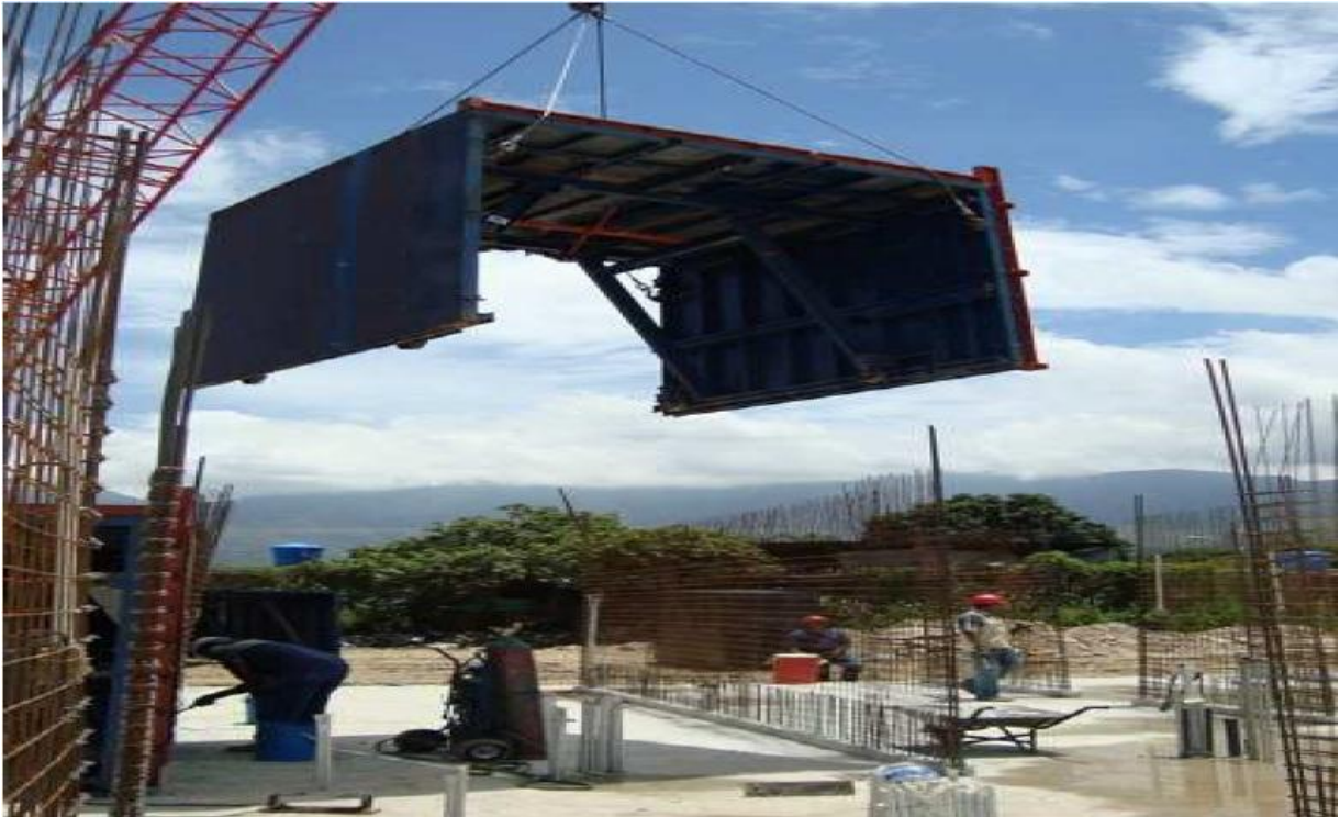
Figura II. 6: Utilización de Grúa para levantamiento de encofrado, Fuente Sparthaco Haack
