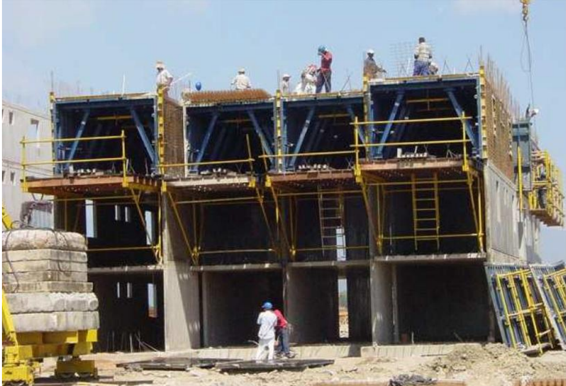
Figura II. 11: Plataforma de desencofrado, Fuente Sparthaco Haack
