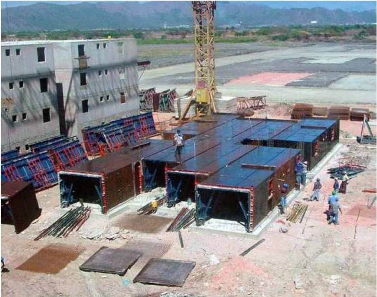
Figura II. 7: Colocación de los encofrados sobre losa de fundación, Fuente Sparthaco Haack
