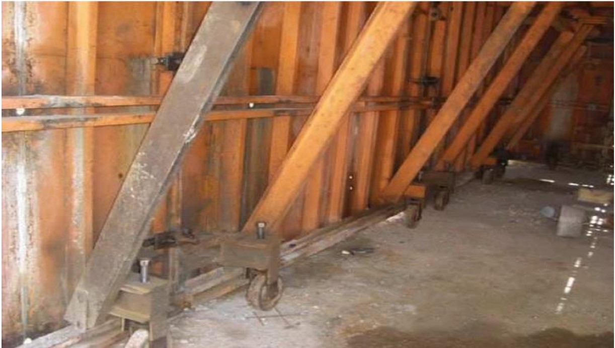
Figura II. 10: Ruedas deslizante de los encofrados tipo túnel, Fuente Sparthaco Haack
