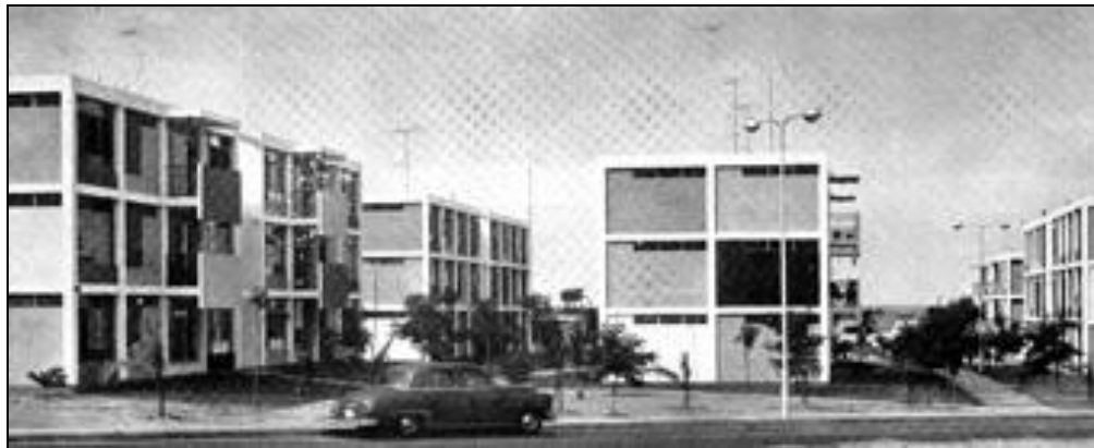
Fig. 30.d. Vista bloques de 3 pisos UV Zapara (1956)
