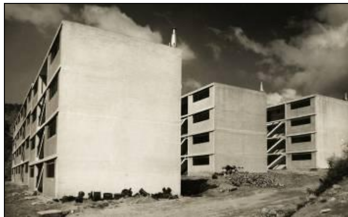
Fig. 16.h. Vista bloques bajos UR Altos de Cútira (1954)
