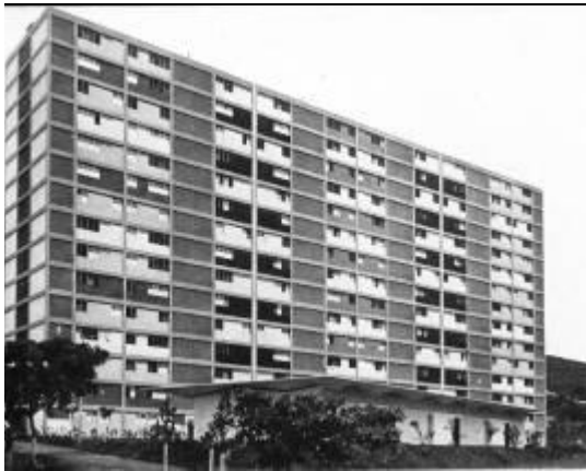
5.j. Vista superbloque UV 24 de Noviembre Este. (1956)
