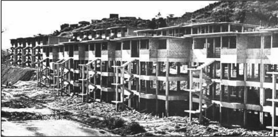
Fig. 45.e. Vista UV Las Vegas de Petare en construcción (1954)
