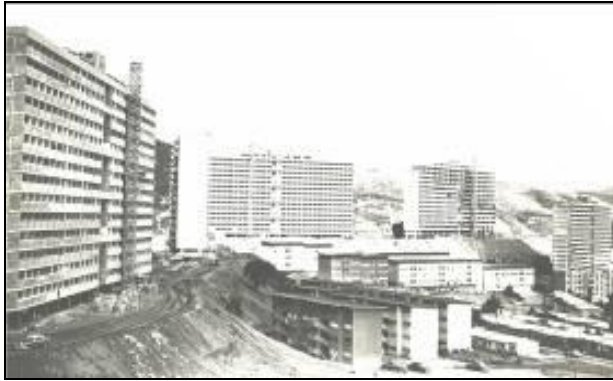
Fig. 102. Superbloques Urb. Lomas de Propatria, en terrazas bajas bloques CT-1 Brisas de Propatria.
