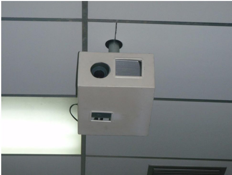
Figura 15. Modelo Coraza Protectora para Equipo de Proyección.
