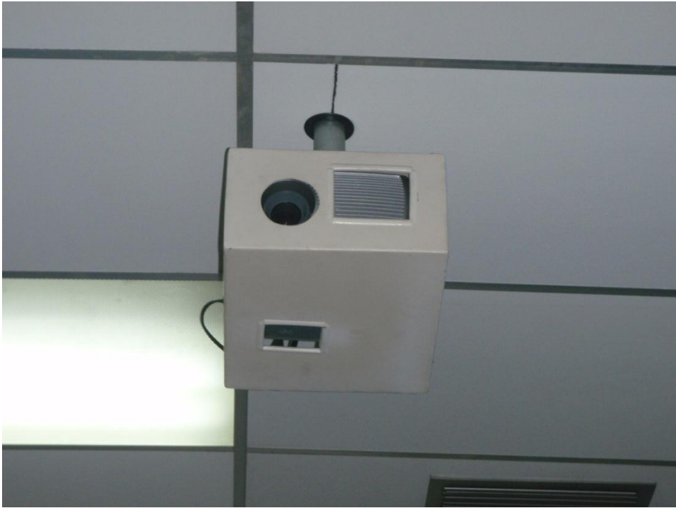
Figura 17. Modelo Coraza Protectora para Equipo de Proyección.
