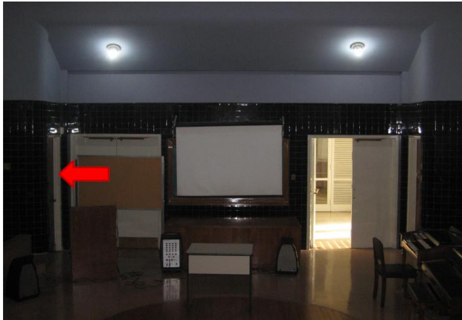
Figura 28. Ubicación Rack Móvil de Equipos.
