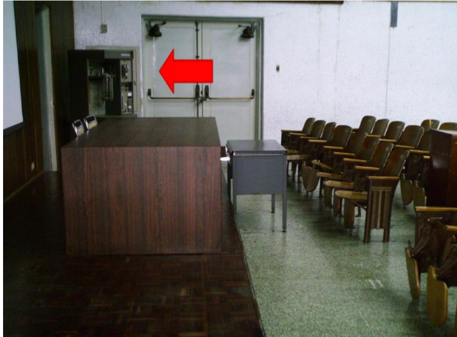
Figura 25. Ubicación Rack Móvil de equipos.
