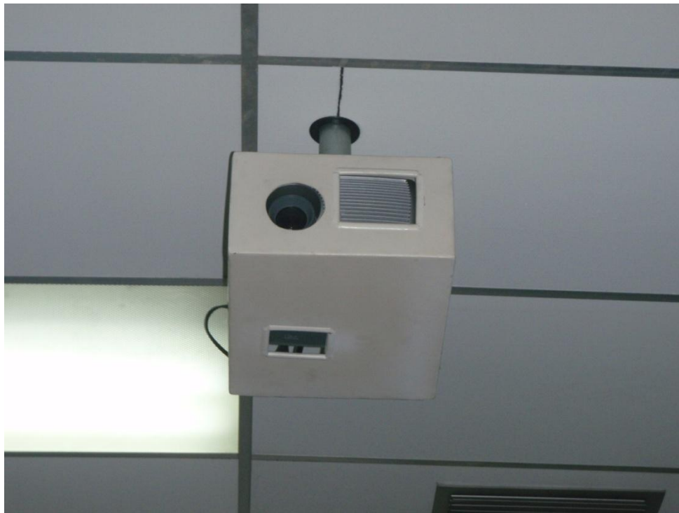
Figura 14. Modelo Coraza Protectora para Equipo de Proyección.
