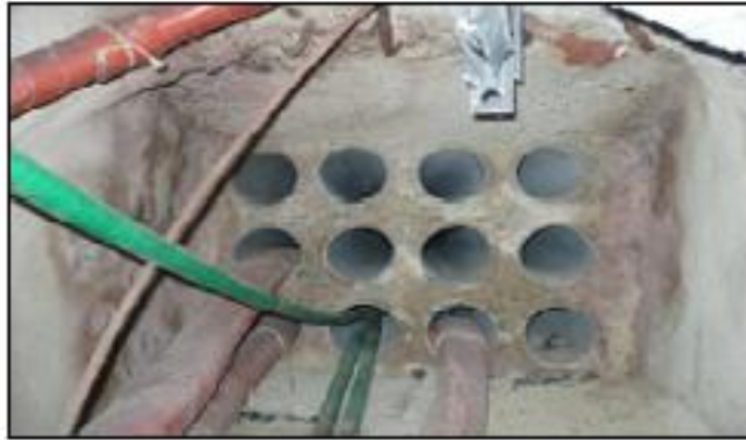
Figura 4. Bancada de la Subestación Conde
