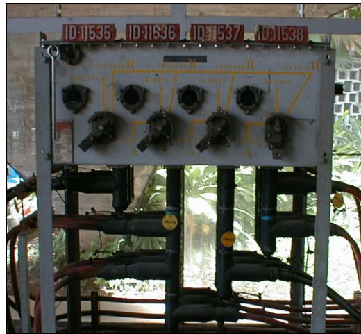
Figura 5. Interruptor 4 vías, sumergible, aislado en aceite
