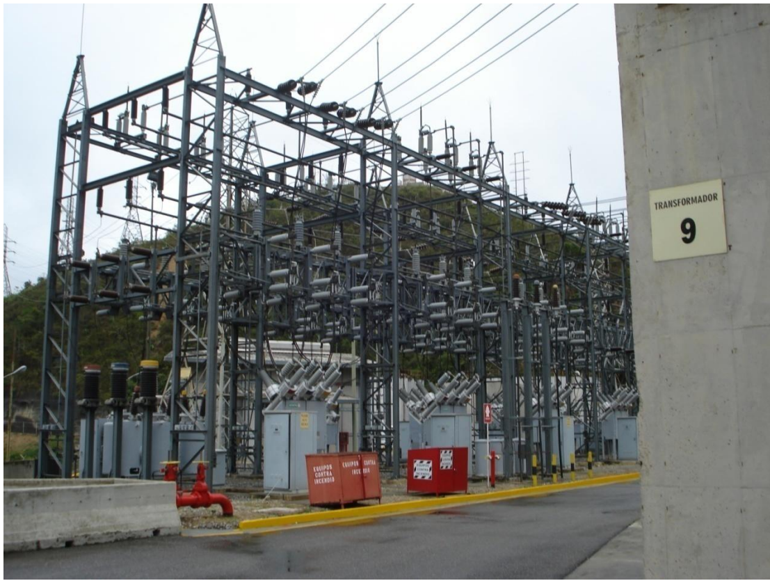
Vista posterior de la S/E OAM.
