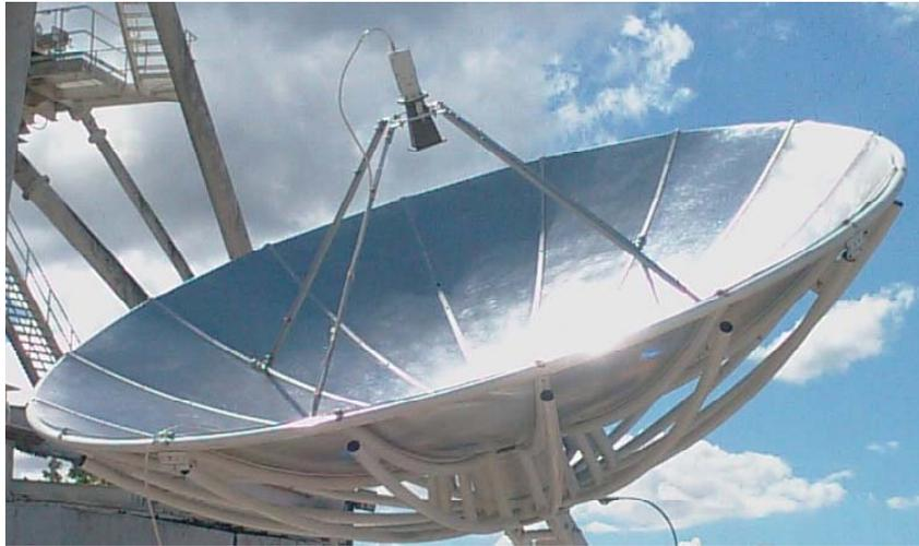
Figura 30: Antena con alimentador del tipo foco centrado
