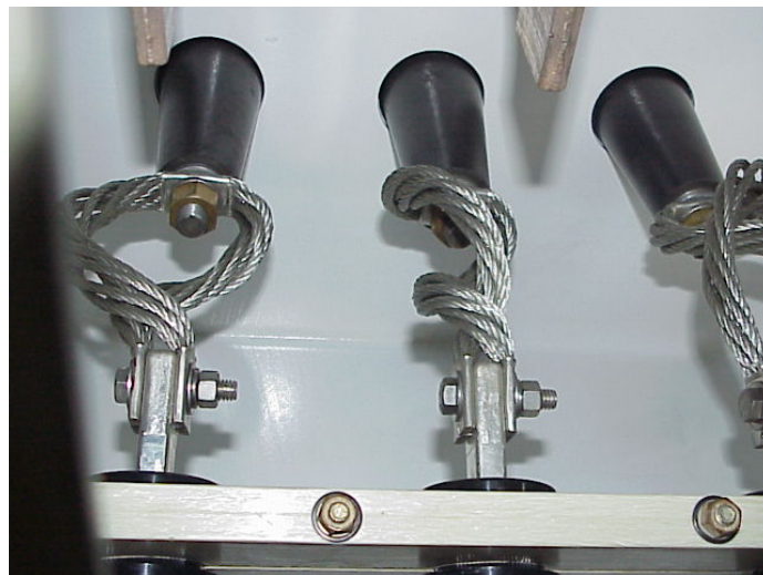
FIGURA 2.28 PROCESO DE ARMADO
