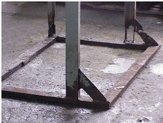
FIGUERA 2.2 BASES DEL SECCIONADOR
