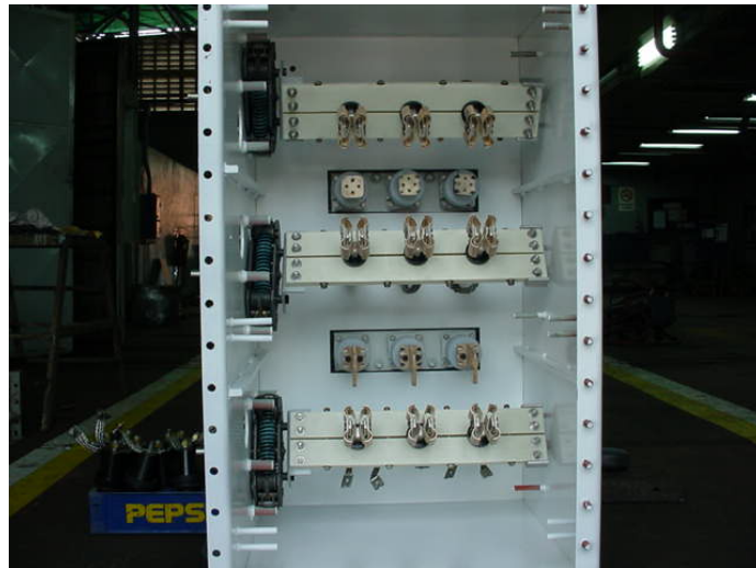
FIGURA 2.31 PROCESO DE ARMADO
