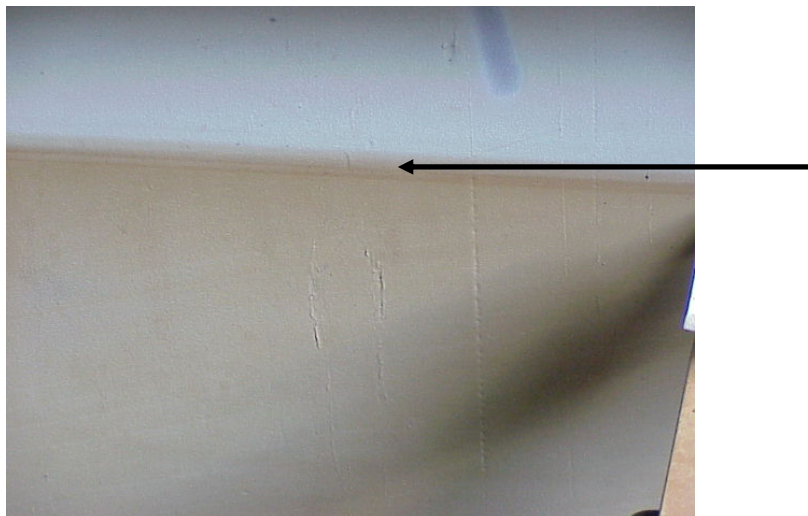
FIGURA 2.9 DIFERENCIA DE COLOR DENTRO DEL TANQUE PRODUCTO DE LA DEGRADACIÓN DEL ACEITE EN SUS AÑOS DE SERVICIO
