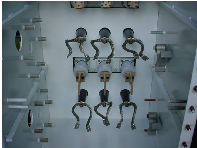
FIGURA 2.24 PROCESO DE ARMADO.
