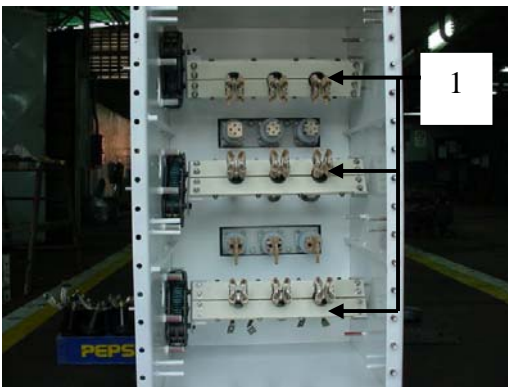
Figura 1.4 Sistema de contactos móviles (1).
