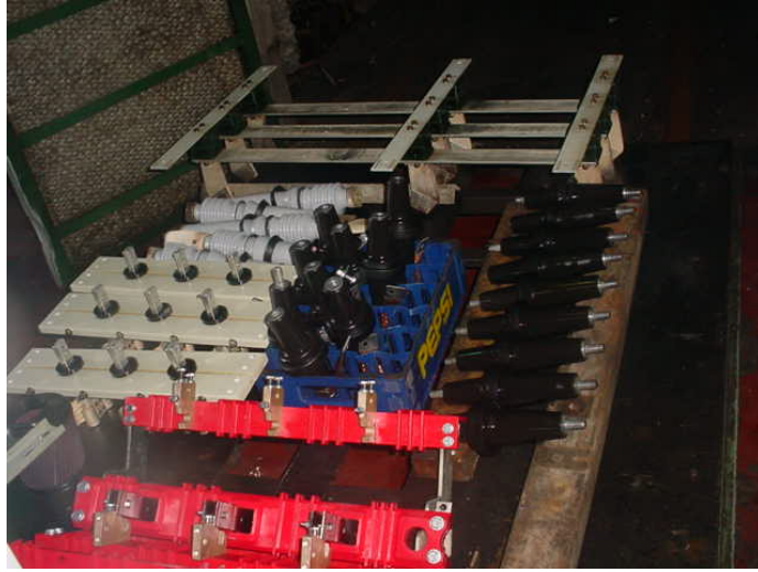
FIGURA 2.23 COLOCACION DE LAS PARTES DESINCORPORADAS EN EL HORNO.
