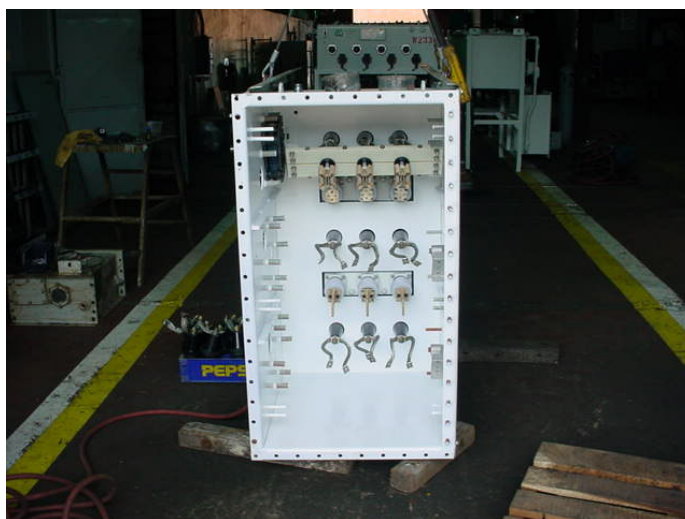
FIGURA 2.30 PROCESO DE ARMADO
