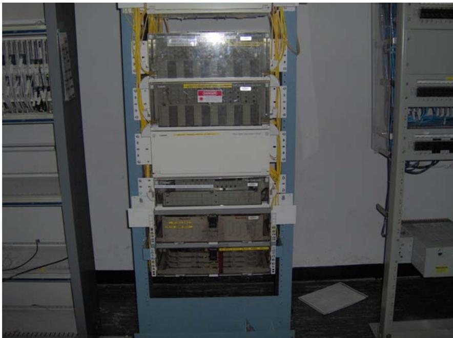
*Figura 6.3 Distribuidor de Fibra Óptica.*
