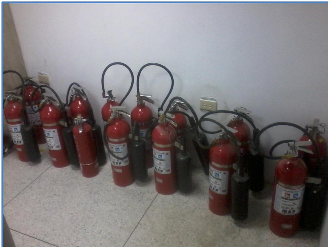
**Figura N° 21.** Extintores bajo proceso de inspección.
