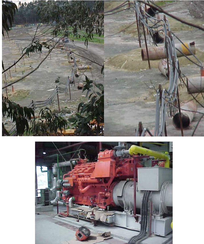
Figura 9. Composición gráfica que incluye el Relleno Sanitario de Oviedo, España, tuberías de captación del Biogás y los motores/generadores de electricidad.
