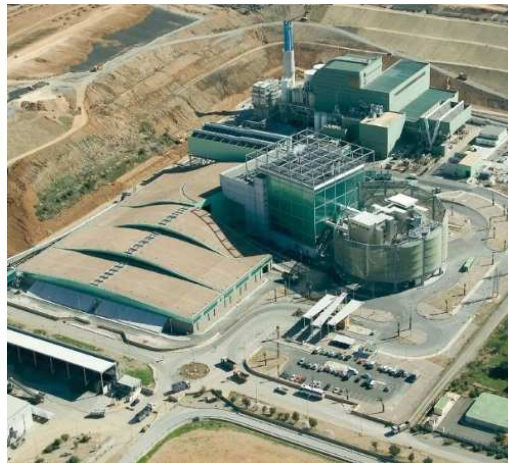
Figura 15. Instalaciones del complejo industrial de Incineración de Palma de Mallorca.
