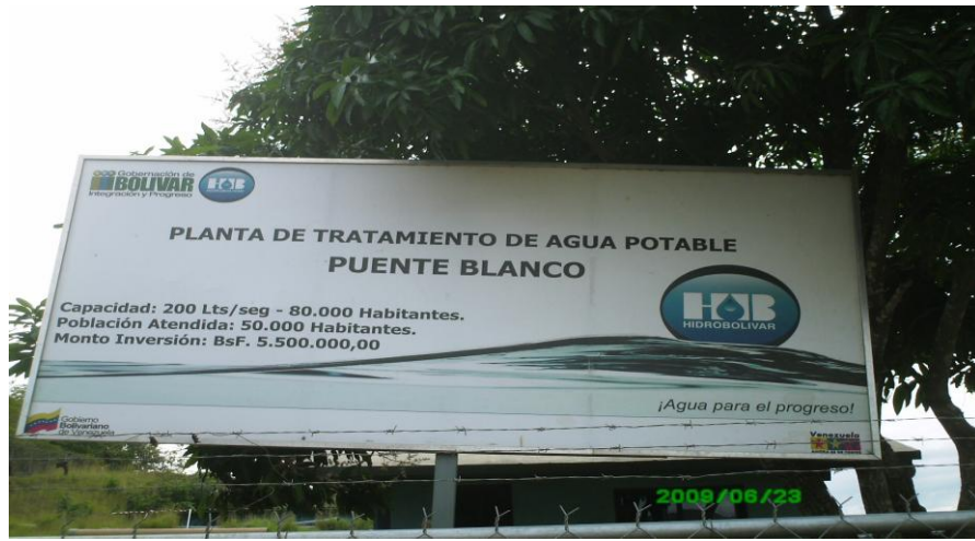
Figura 10. Planta de Tratamiento “Puente Blanco”
