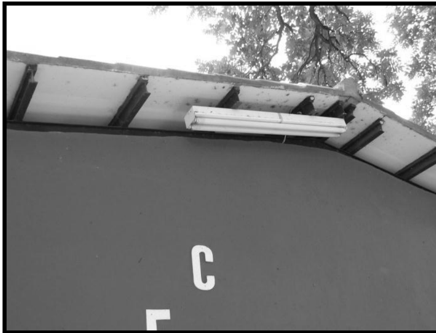
Fotografía C.24. Edificación 1. Parte de la Fachada Sur.
