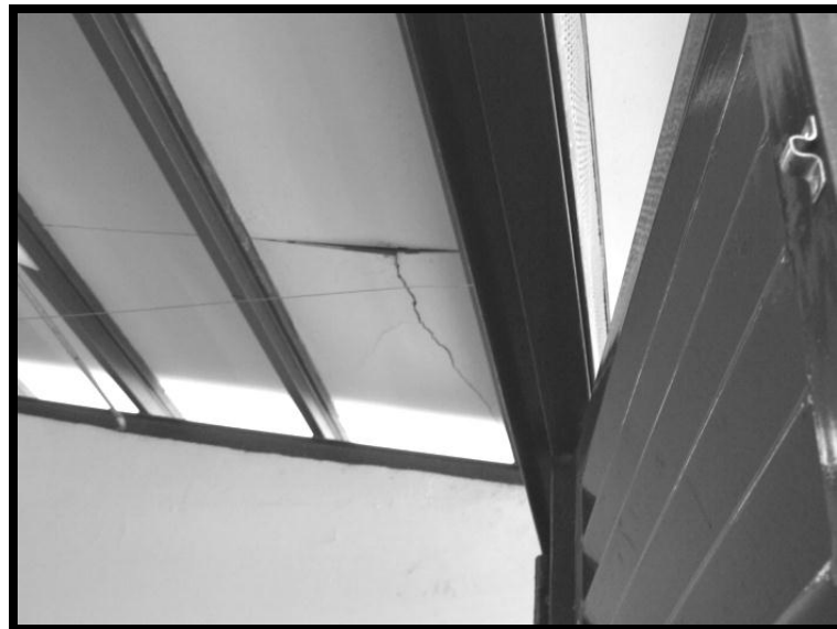
Fotografía C.38. Edificación 1. Detalle de la disposición horizontal de las vigas de arriostramiento entre los pórticos transversales de la edificación. La Edificación 1 presenta ciertas variaciones respecto de los modelos de Escuelas tipo R, pero difiere mucho menos de estos últimos que la Edificación 2.
