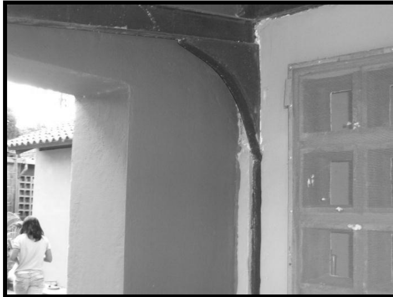
Fotografía C.41. Edificación 2. Vista de la cartela formada por chapas metálicas para el soporte del alero.
