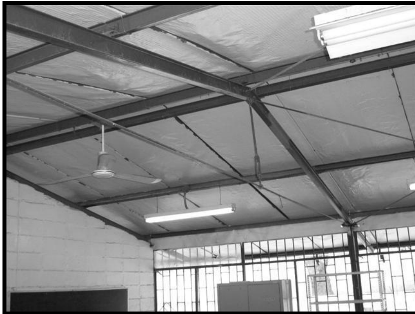
Fotografía C.3. Edificación 1. Tensores de barras macizas para arriostramiento de pórticos transversales. Se aprecia grandes espaciamentos entre correas.
