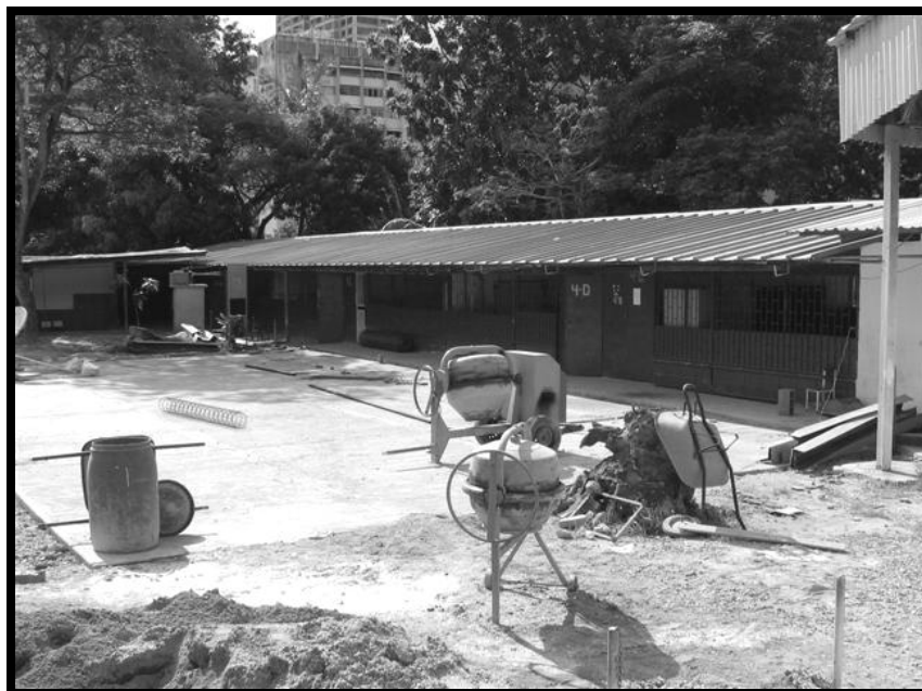
Fotografía C.2. Edificación 1. Fachada Este. Edificación de 4 aulas (R-4) de cubierta liviana de láminas metálicas corrugadas. Vista hacia el Sur-Oeste.
