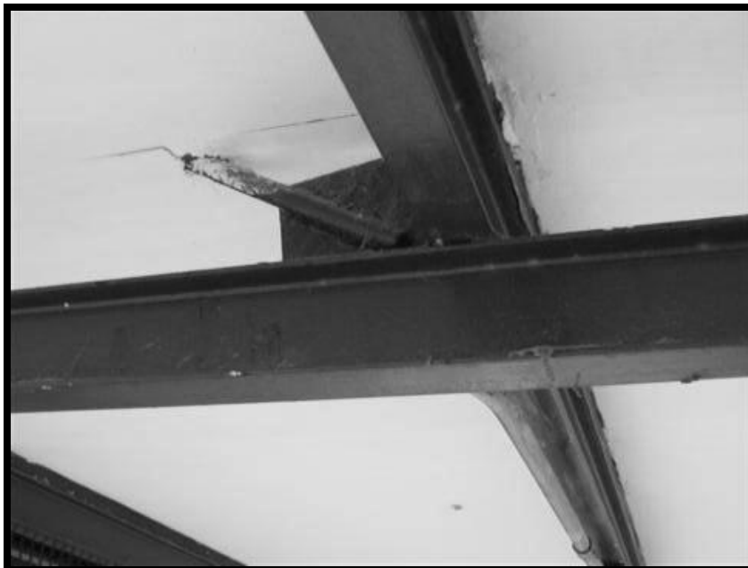
Fotografía C.32. Edificación 1. Detalle de la conexión del tensor del alero. Vista de la cara inferior del alero.
