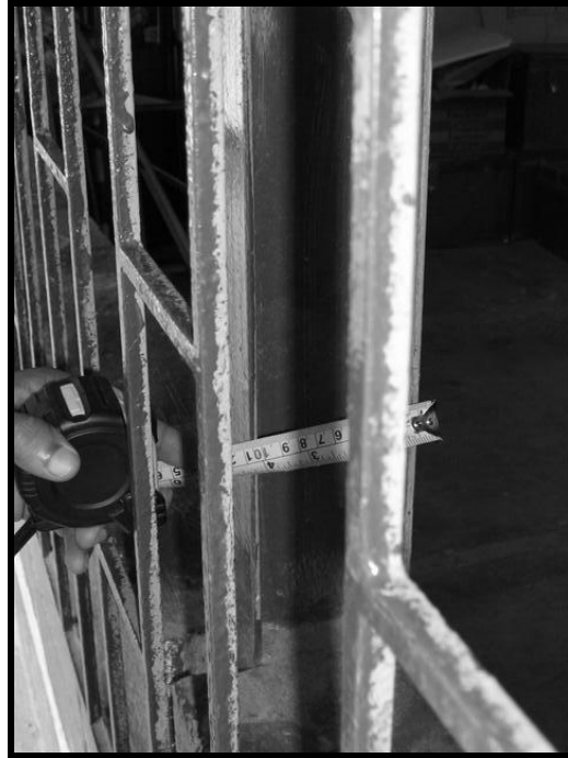
Fotografía C.13. Edificación 4. Uso de perfil metálicos tipos IPN100 para columnas. Caso análogo con la Edificación 3.
