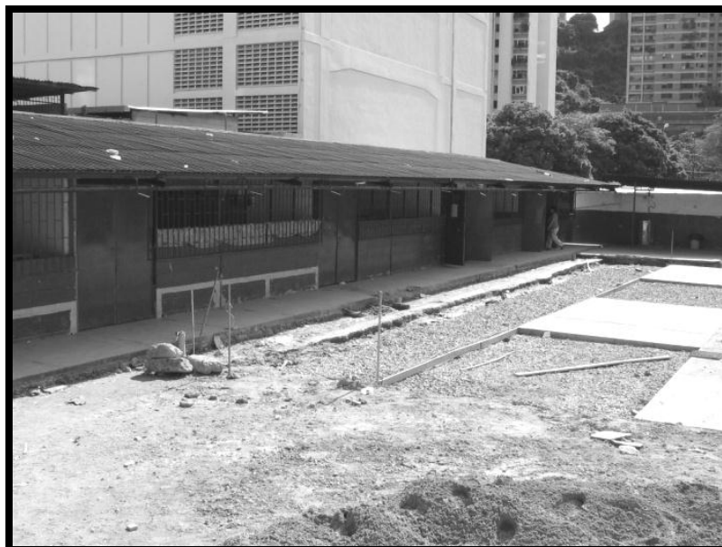
Fotografía C.7. Edificación 2. Fachada Oeste. Estructura con ciertas similitudes a las Escuelas Tipo R Tradicional (R-4), (FEDE, s.f. a). Posee cubierta de techo liviana de láminas metálicas corrugadas, posiblemente de tipo acero recubierto con asfalto y aluminio por ambas caras. Vista hacia el Sur-Este.
