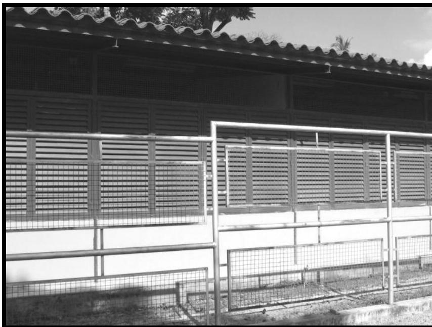
Fotografía C.34. Edificación 1. Fachada Este. Vista desde el Este hacia el Oeste.
