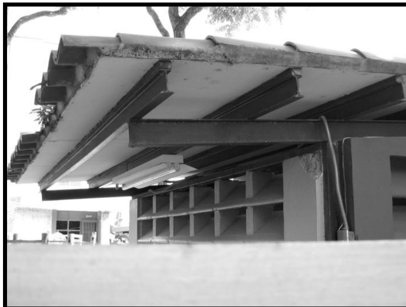
Fotografía C.26. Edificación 1. Vista de la cubierta de techo y distribución de los perfiles metálicos tipo I en el extremo del baño anexo. Fachada Oeste.
