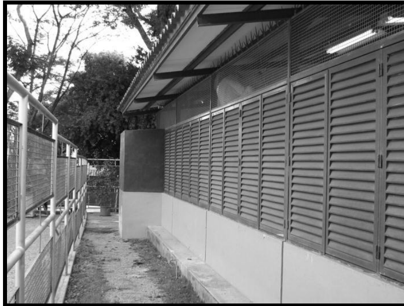
Fotografía C.35. Edificación 1. Fachada Este. Vista desde el Norte hacia el Sur.
