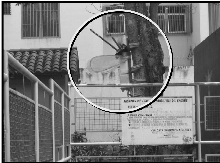
Fotografía C.45. Elemento no estructural ornamental (forma de insecto). Elemento ubicado sobre el tronco de este árbol, y que pudiera vulnerar la vida de los niños a la hora de un sismo severo.
