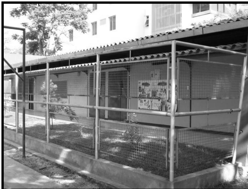
Fotografía C.44. Edificación 2. Fachada Sur. Vista hacia el Norte-Oeste.
