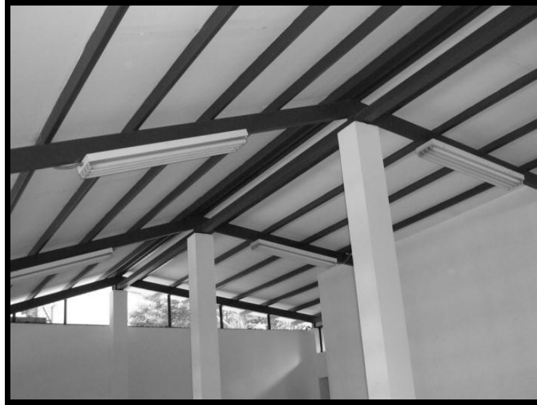
Fotografía C.21. Módulo de Comedor. Distribución de los tubos rectangulares tipo CONDUVEN para correas y las vigas de carga. Presenta columnas de concreto en la parte central, y sobre estas y bajo las vigas de carga se presentan vigas de amarre de tubos rectangulares tipo CONDUVEN en la dirección larga.
