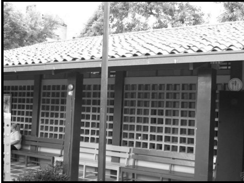
Fotografía C.19. Módulo del comedor. Fachada Lateral Este. Vista hacia el Sur-Oeste.
