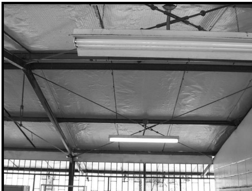
Fotografía C.4. Edificación 1. Tensores de arriostramiento diagonal. Dispuestos en ambos planos de la cubierta de techo, en uno de los módulos extremos de la edificación.
