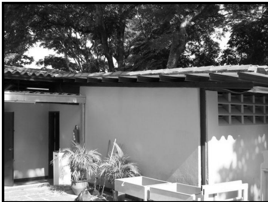
Fotografía C.28. Edificación 1. Fachada Norte y Oeste del baño anexo (sanitarios). Vista Sur-Este
