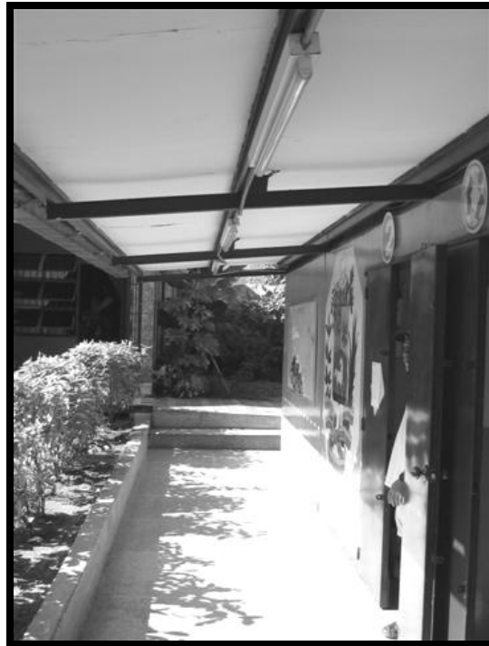
Fotografía C.29. Edificación 1. Pasillo de circulación. Fachada Este.
