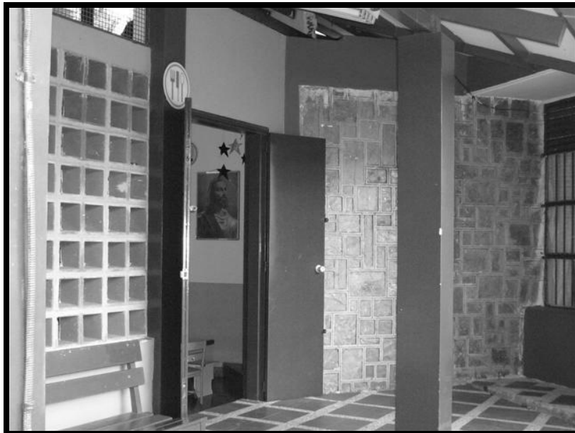
Fotografía C.22. Módulo de Comedor. Puerta Norte de acceso al comedor. Las columnas del comedor son de concreto con una conexión metálica empotrada en su tope.
