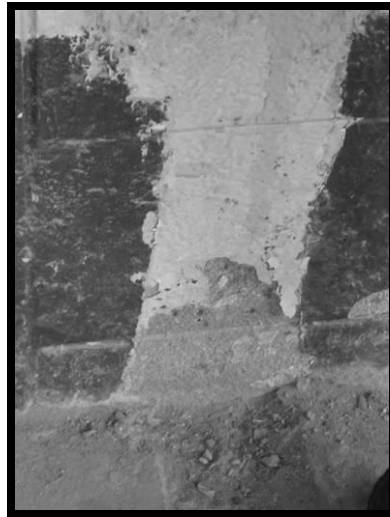
Fotografía C.1. Mampostería de bloques de concreto.
