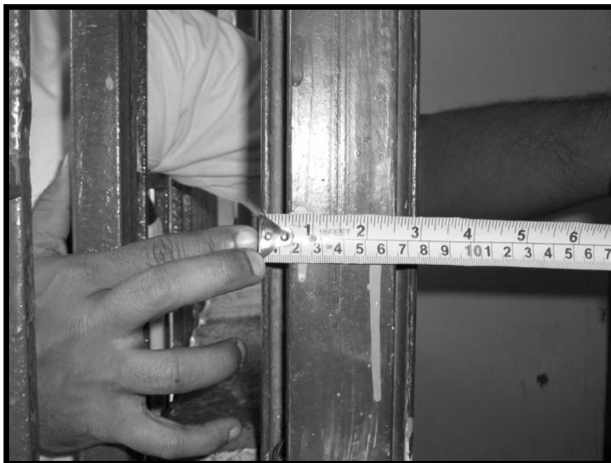
Fotografía C.10. Edificación 2. Columnas de perfiles metálicos tipo IPN80.
