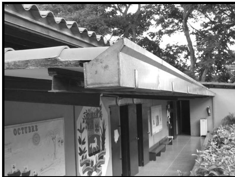
Fotografía C.30. Edificación 1. Pasillo de circulación con vista hacia el baño anexo. Vista hacia el Sur.
