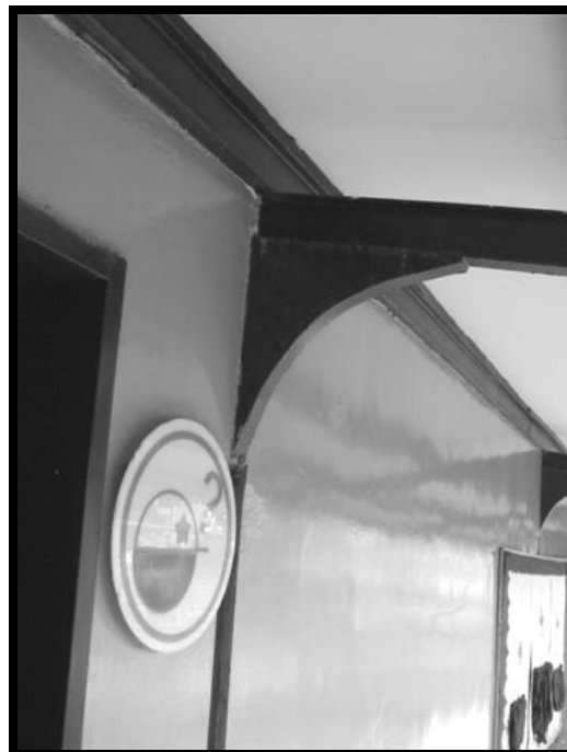
Fotografía C.42. Edificación 2. Otro detalle de las cartelas.
