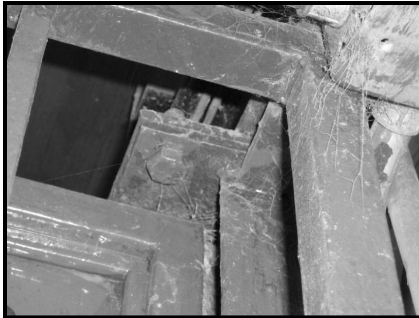
Fotografía C.9. Edificación 2. Empernado de los elementos metálicos. Anclaje de las barras tensores de arriostramiento del techo en el tope de una columna.
