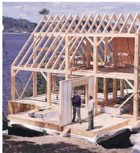
**Figura 2. 18** Sistema poste y viga (Tomado de CORMA, s.f.)
