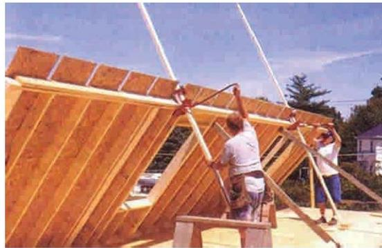
**Figura 2. 14** Ubicación de los tabiques sobre la plataforma (Tomado de CORMA, s.f.)
