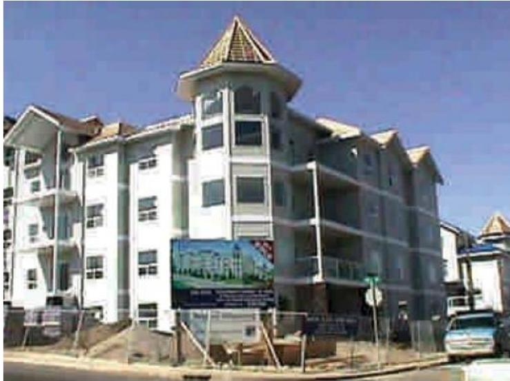
**Figura 2. 1** Edificio de departamentos multifamiliar de cuatro pisos estructurado en madera en 1998, Calgary, Alberta, Canadá (Tomado de CORMA, s.f.).
