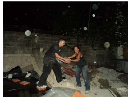
Anexo 6. Colocación de cilindros en piscina de curado.
