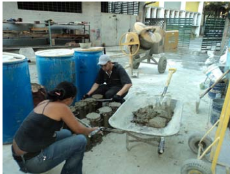
Anexo 2. Vaciado y enrasado de probetas.
