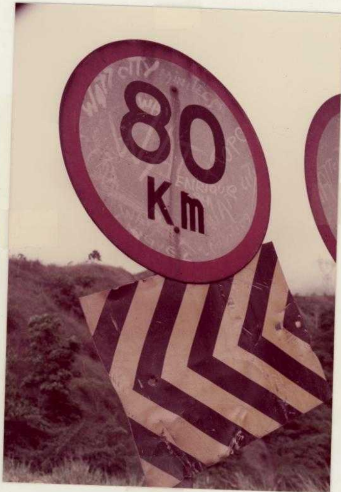
° Señales sin Mantenimiento.
