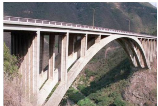
Foto 2. Arcos de concreto armado del Viaducto N° 2 de la Autopista Caracas-La Guaira.
