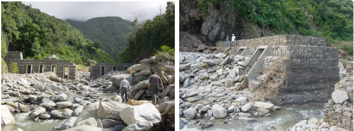
Foto 18. Vista de la presa de Camurí Chico desde aguas abajo (izquierda) y de la abertura central de la presa desde aguas arriba (derecha). (Tomada por: El Instituto de Mecánica de los Fluidos)
