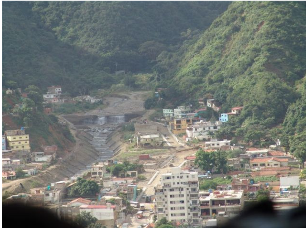
Foto 20. Panorámica de la presa de control de sedimentos y canalización de gaviones en el Río Macuto (San José de Galipán). (Tomada por: El Instituto de Mecánica de los Fluidos).
