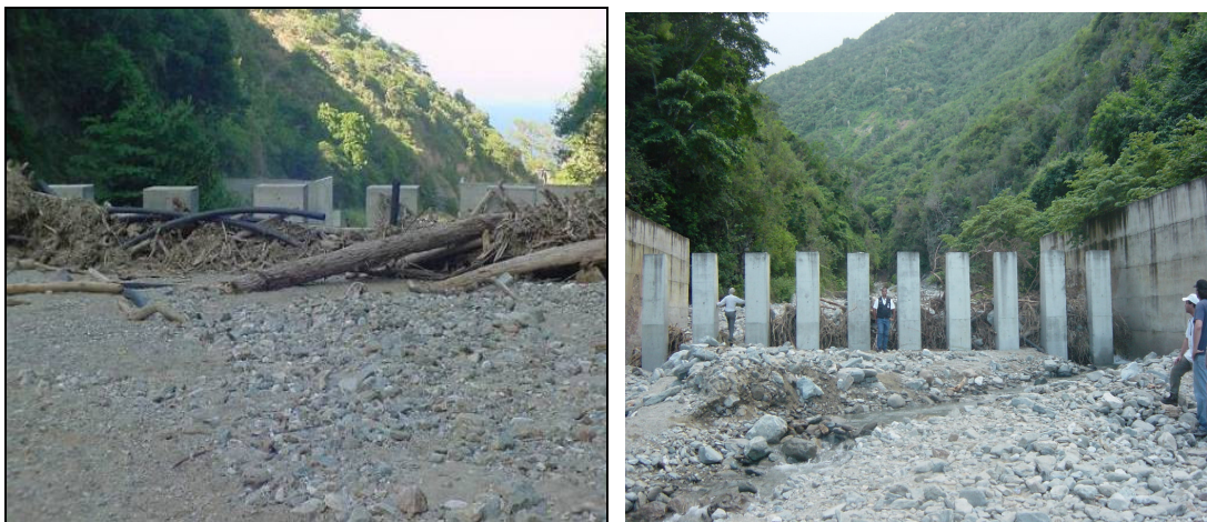
Foto 16. Presa Guanape: Vista del vaso sedimentado en Diciembre 2001 y después de la creciente de Febrero 2005, de izquierda a derecha. (Tomada por: El Instituto de Mecánica de los Fluidos)
