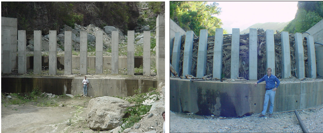
Foto 15. Vistas desde aguas abajo de la Presa Guanape en dos diferentes épocas: después de finalizada la construcción en Mayo 2001 y Después de la creciente de Diciembre 2001, de izquierda a derecha. (Tomada por: El Instituto de Mecánica de los Fluidos)
