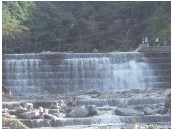
Foto 2. Presa cerrada en Venezuela funcionando en condiciones hidráulicas normales (Tomada por: El Instituto de Mecánica de los Fluidos en Febrero del 2.005)
