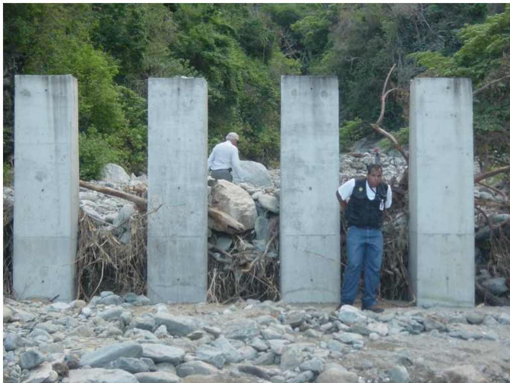
Foto 13. Presa ranurada en Venezuela funcionando en condiciones hidráulicas normales (Tomada por: El Instituto de Mecánica de los Fluidos en Febrero de 2.005)
