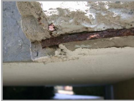
**Imagen 2.3. Corrosión del acero de Refuerzo**
