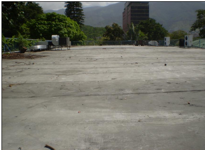
Foto 4.4.15: Azotea cuerpo principal del edificio
