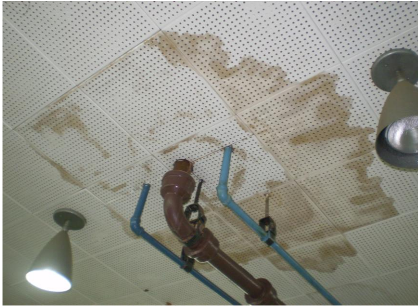
Foto 4.7.2. Filtración en aula del piso 8
