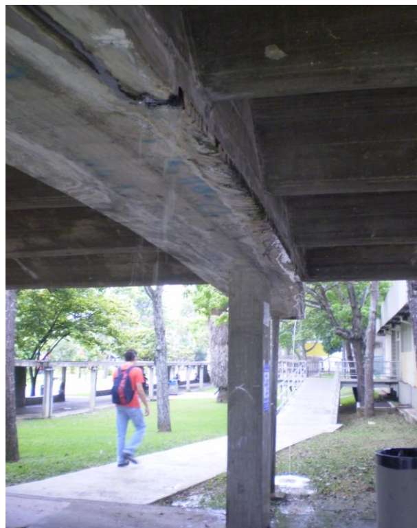
Foto 4.5.9. Drenaje del agua sobre el pasillo.
