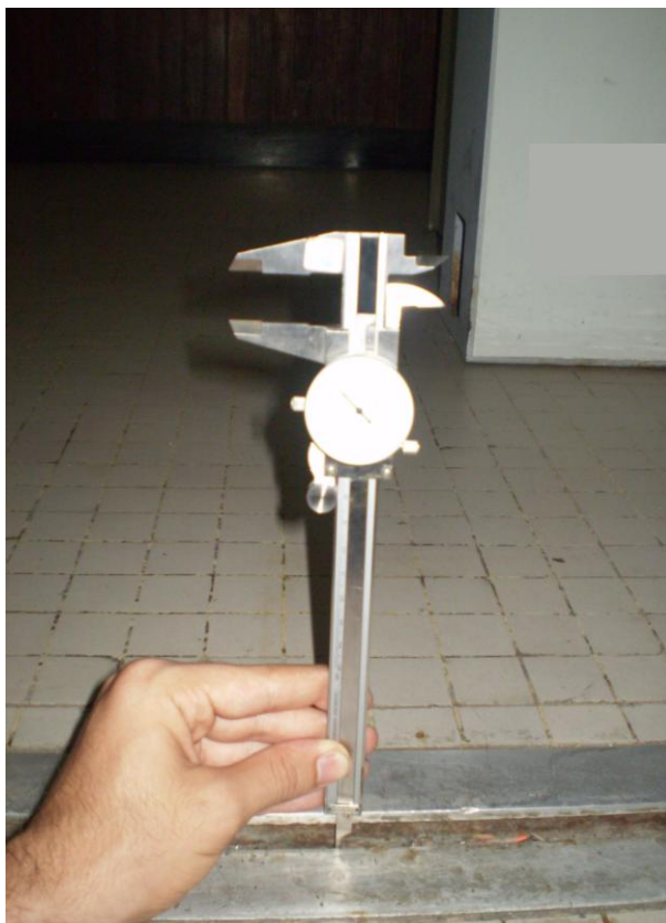
Foto 4.9.16. Medición del asentamiento a lo largo de la junta.
