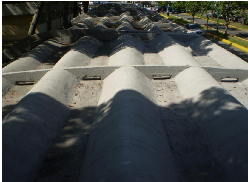
Foto 4.5.6. Buen estado de la impermeabilización.
