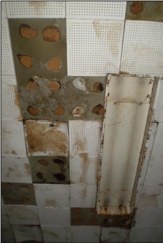
Foto 4.8.9. Filtración y desprendimiento del acabado Foto 4.8.10. Filtración y desprendimiento del acabado
