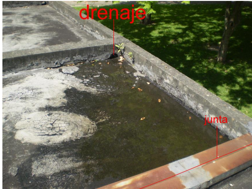
Foto 4.2.10. Formación de pozos por cambio de pendiente.
