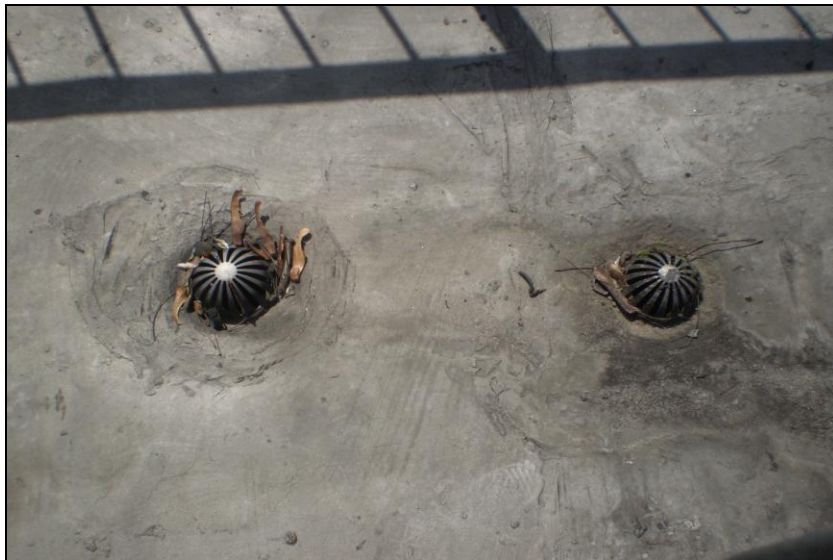
Foto 4.4.8: Drenajes en la azotea principal del edificio.
