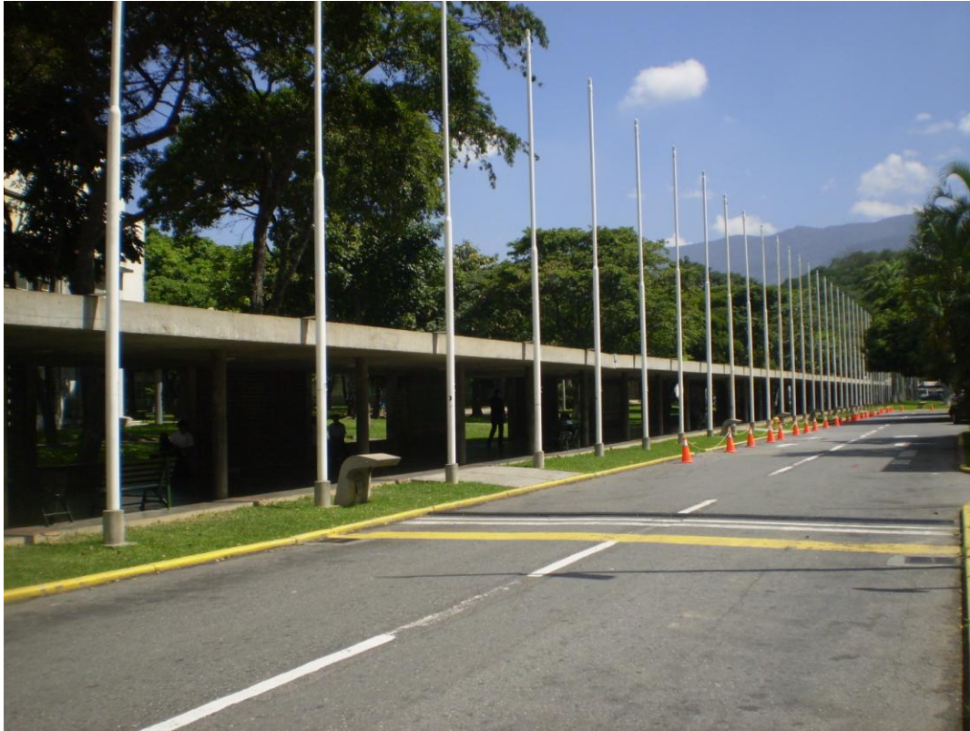
Foto 4.2.1. Pasillo adyacente a la Av. Las Banderas
