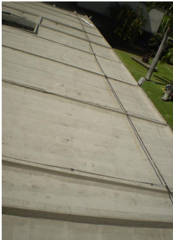
Foto 4.3.3. Estado del acabado de impermeabilización
