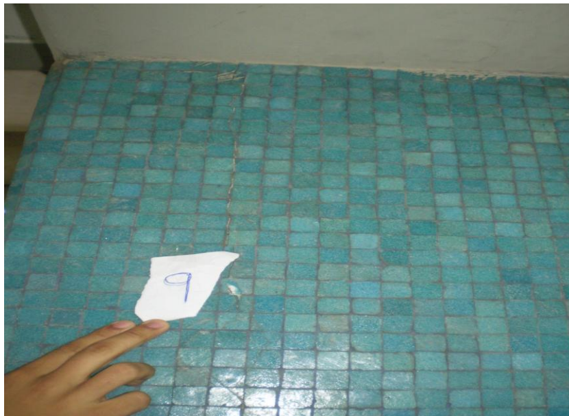
Foto 4.7.3. Fisura en pared interna del piso 4
