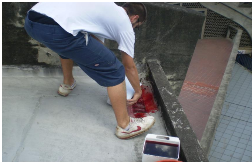
Foto 4.8.14. Derrame de agua con colorante rojo por los drenajes.
