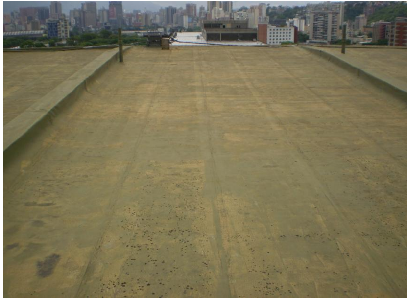
Foto 4.7.4 Estado actual de la azotea.
