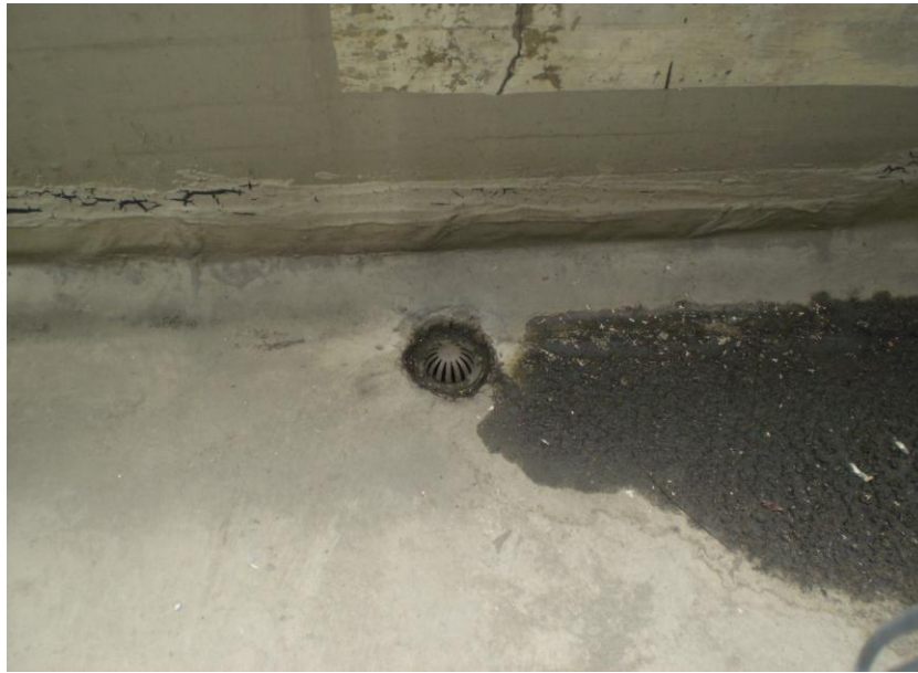
Foto 4.9.9. Drenaje en la azotea del anexo.
