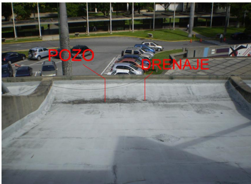
Foto 4.6.6. Formación de pozos alrededor del drenaje.
