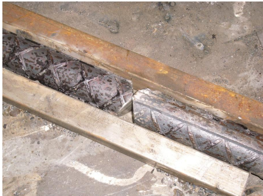
6.- Colocación del bisel doble antes de soldar.
