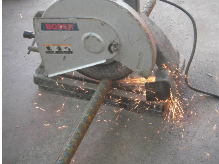
1.- Proceso de corte de las barras.
