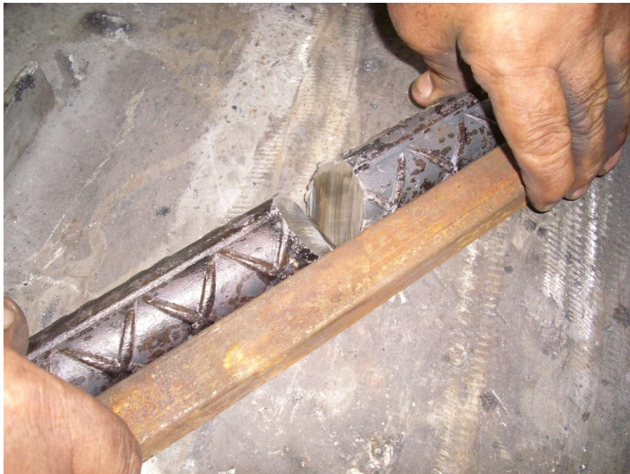
4.- Colocación del bisel sencillo antes de soldar.
