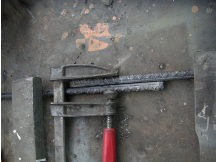
7.- Colocación de las barras antes de ser soldadas a solape con cordón simple.
