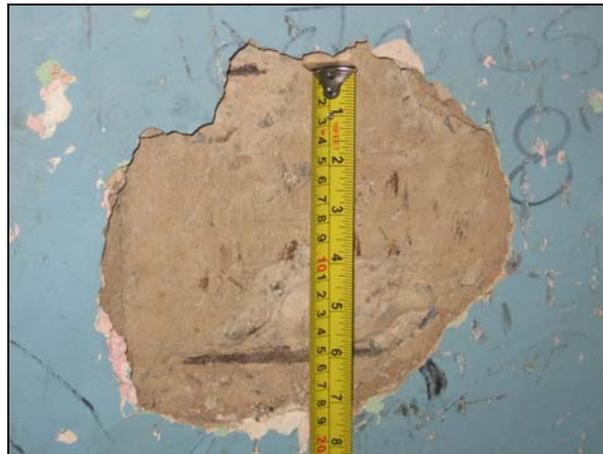
Figura IV.1.12. U.E.N. José Rafael Revenga. Edificio I. Planta Baja. Fachada Oeste. Se observa el levantamiento del friso, la corrosión del acero transversal y su separación (15 cm.).
