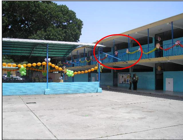
Figura IV.2.5. U.E. Rafael Briceño Ortega. Edificio único. Se observa la cancha apoyada en la losa del edificio.
