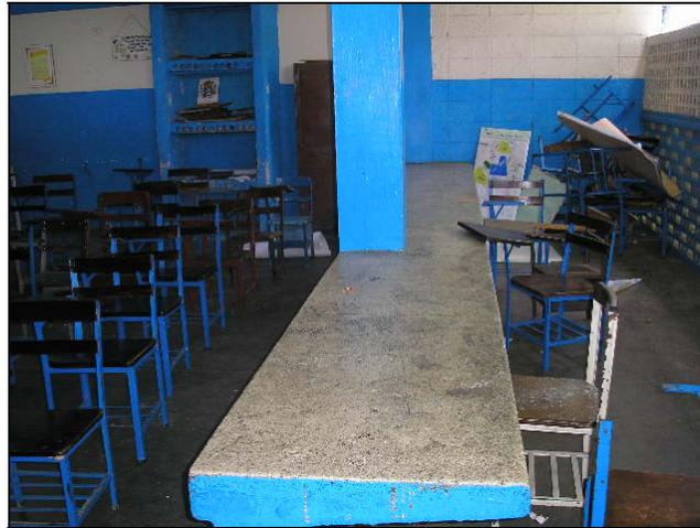
Figura V.1.6. U.E. Luís Alejandro Alvarado. Planta Baja. Se observa el banco de concreto empotrado a dos columnas internas de un salón.
