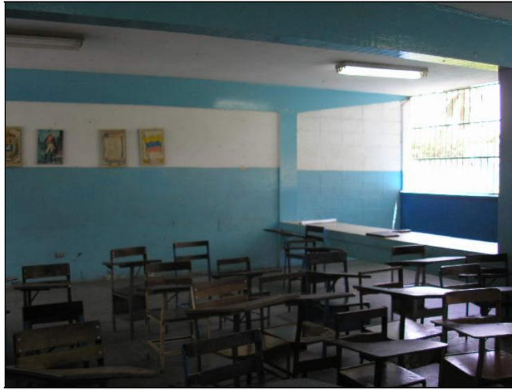
Figura V.1.5. U.E. Luís Alejandro Alvarado. Planta Baja. Se observa la parte central de la viga con sección constante y el volado con sección variable.
