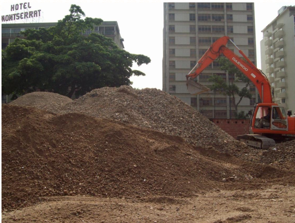
Foto N°6: Ilustración del almacenamiento en pilas de los residuos pétreos de materiales de construcción procesados
