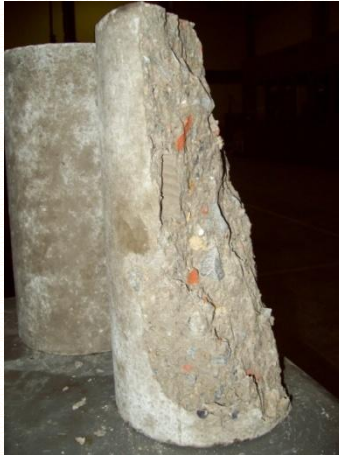
Foto N°16: Ilustración de una probeta ensayada a compresión, de la mezcla de resistencia de diseño de 250 \text{ kgf/cm}^2 , a la edad de 7 días, con agregados Tipo II. El cilindro presentó una falla de tipo (2), ver figura N°2
