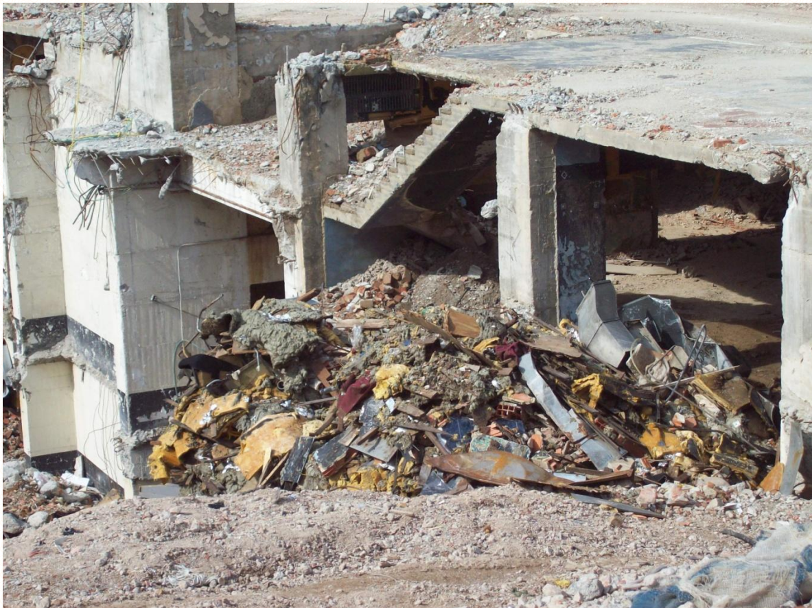
Foto N°3: Ilustración de una demolición selectiva, clasificación de los elementos no fijos
