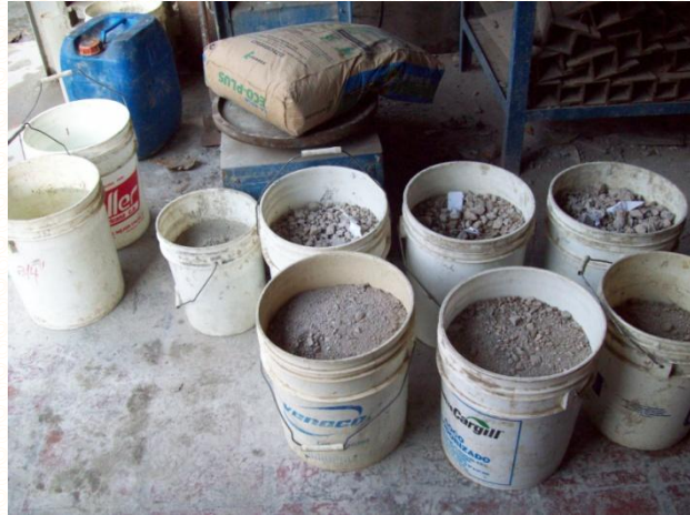
Foto N°11: Ilustración de la dosificación de agregados y cemento de la mezcla de 280 \text{ kgf/cm}^2 , con agregados Tipo II
