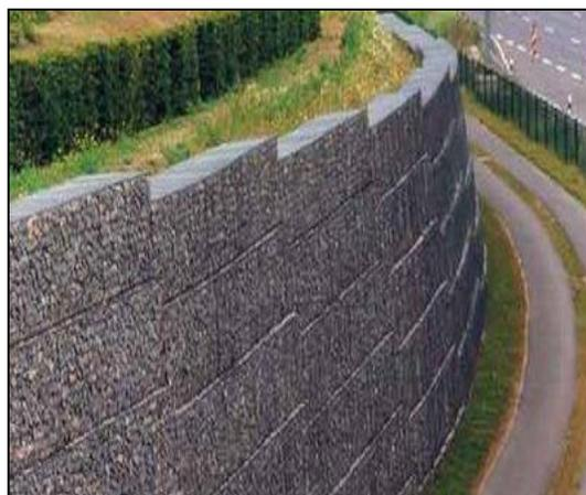
Figura 5.2 Muro de gavión
