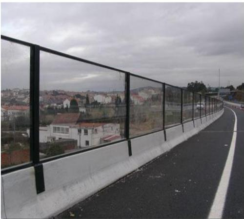
Figura 5.1 Pantalla de policarbonatos
