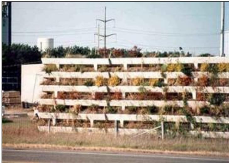
Figura N° 5.3 Barrera de Concreto Poroso
