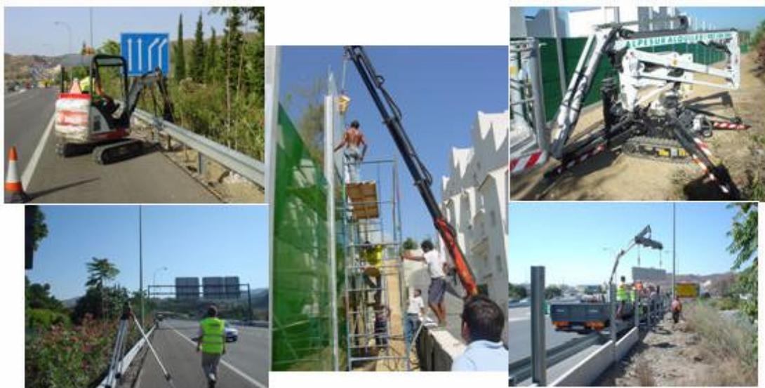
FIGURA 4.9 Maquinaria utilizada comúnmente para instalación de pantallas acústicas en vías expresas.
