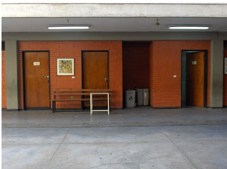
Imagen 008. Paredes internas de baños 2,45 mts de altura (alcanzan vigas altas)
