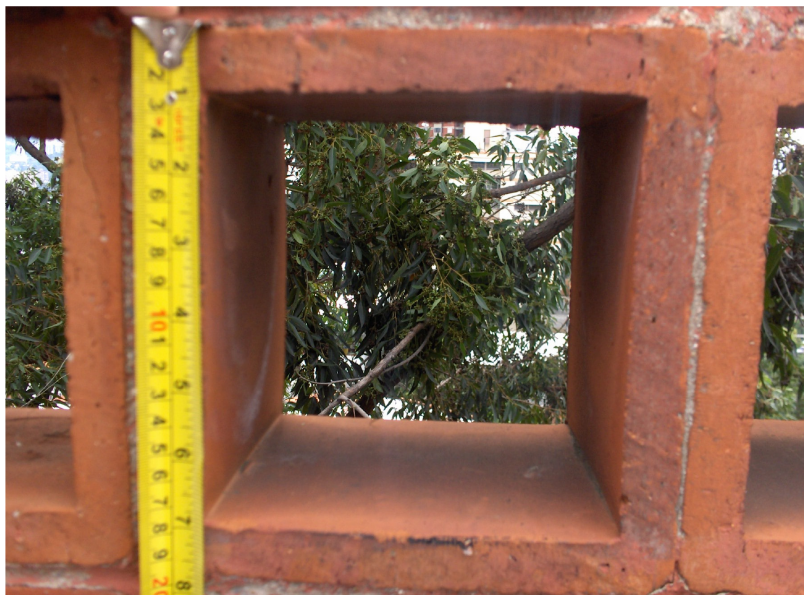
Imagen 012. Detalle del bloque de ventilación.
