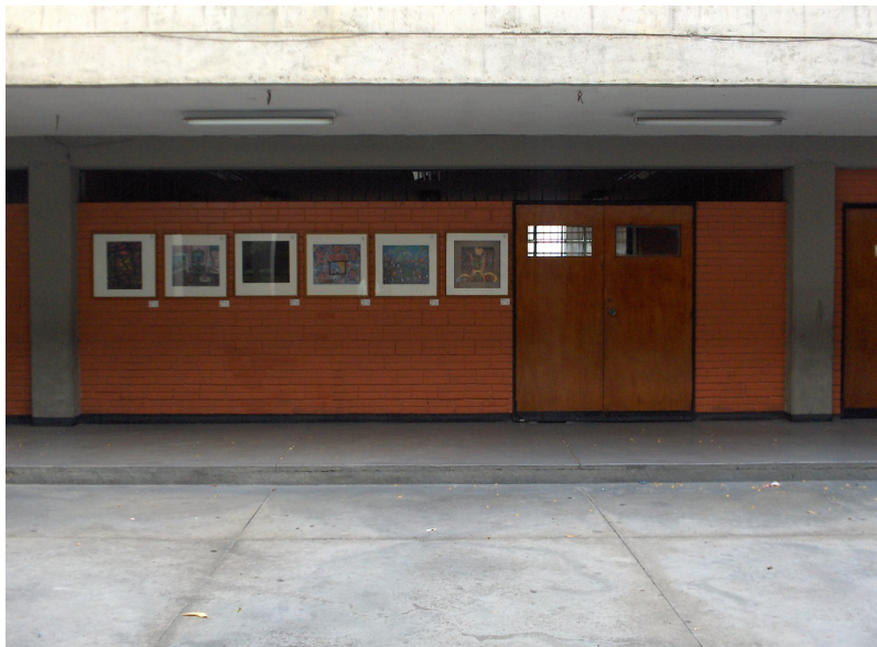
Imagen 007. Paredes internas de aulas de 2,10 mts de altura
