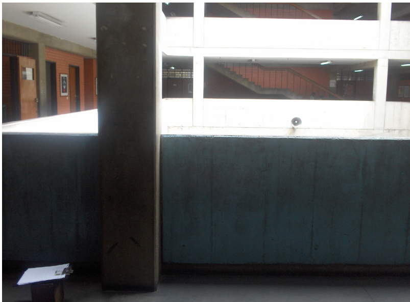
Imagen 016. Muros en pasillos de niveles 1 y 2,
