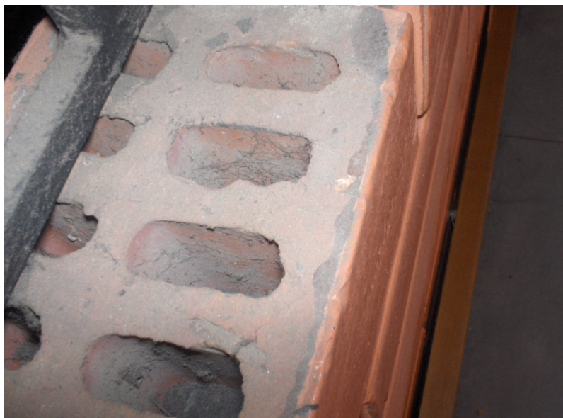
Imagen 009. Paredes internas con bloques de arcilla de 12 cm de espesor
