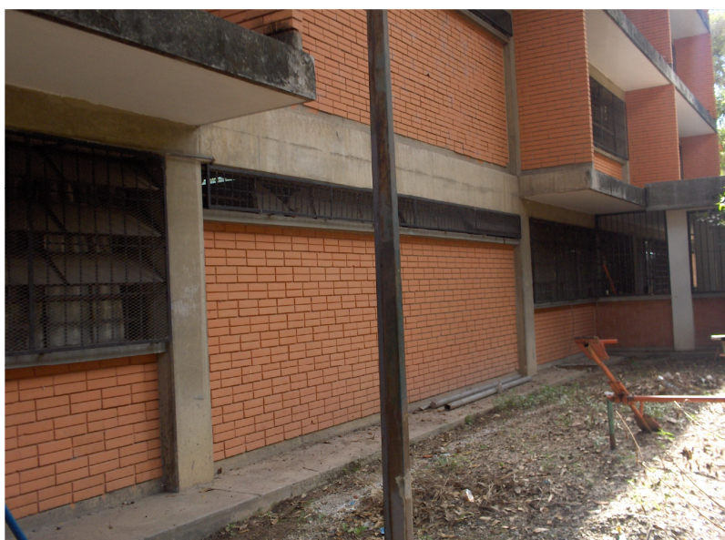
Imagen 006. Paredes externas de baños de 2,10 mts de altura
