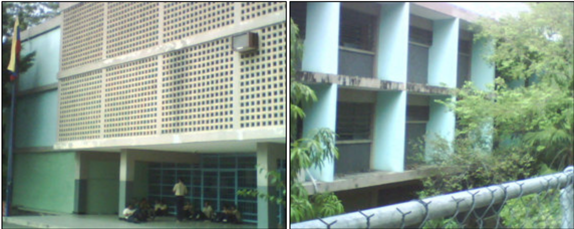
Figura IV.3. Fotografías de las fachadas principales del Escuela Técnica Licenciado Aranda. La Guaira.
