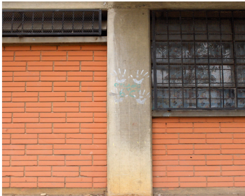
Imagen 020. Columna lateral fachada norte
