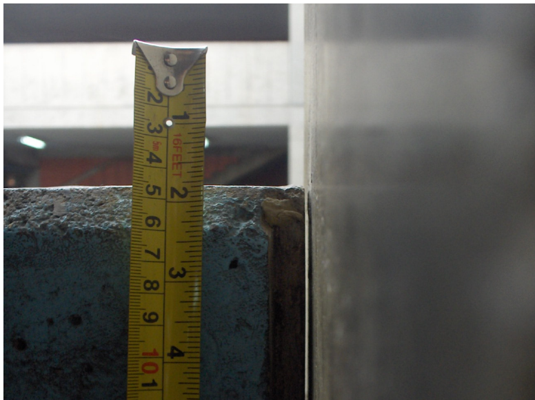
Imagen 017. Detalle de la separación entre muros y columnas centrales
