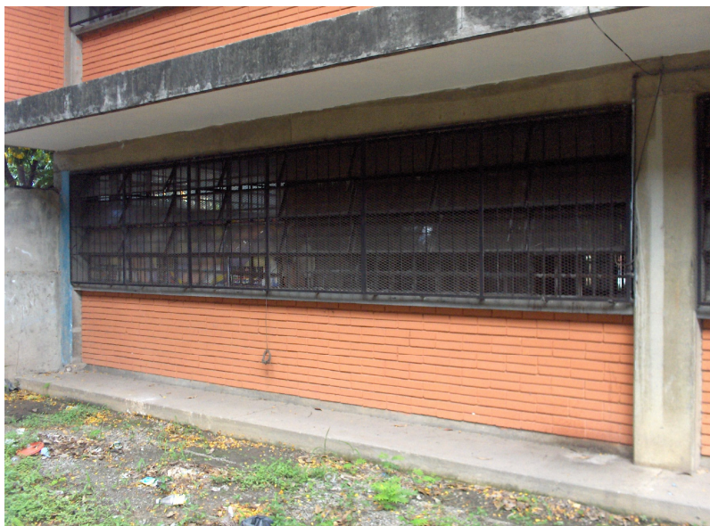
Imagen 005. Paredes externas de aulas de 1,10 mts de altura.
