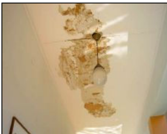
Imagen A.32. Techo falso de madera, Planta alta, Patio Venezuela, Centro. Fuente: Los Autores
