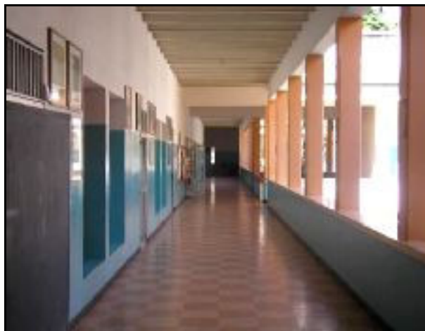
Imagen A.24. Pasillo longitudinal Sur-Este. Vista al Oeste.
