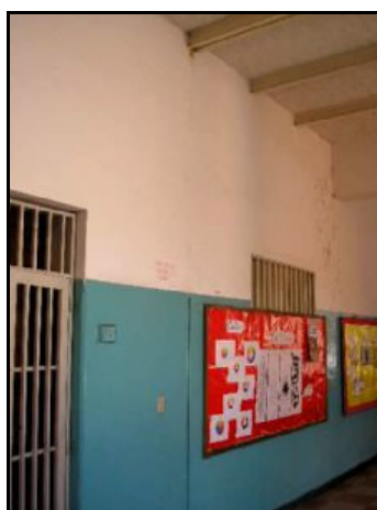
Imagen A.6. Se observa el detalle de la prolongación de la junta estructural en la pared, y la presencia de vigas de aceros en la planta alta.
