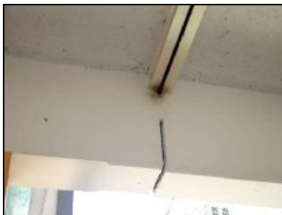
Imagen A.7. Se observa detalle de la Junta estructural .Patio Venezuela .Planta alta .Sur.
