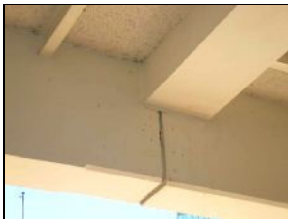
Imagen A.8. Detalle de la Junta estructural y viga falsa. Planta alta. Patio Venezuela. Norte.
