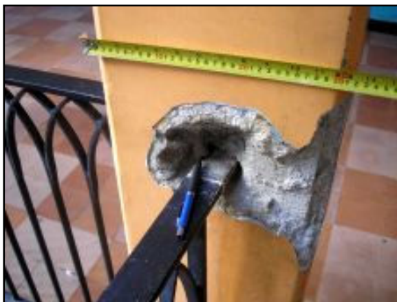
Imagen A.30. Columna Patio América, esquina Sur-Oeste. Planta baja. Vista al Sur.
