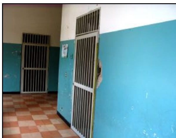
Imagen A.28. Pasillo, planta alta Oeste, vista al Sur.
