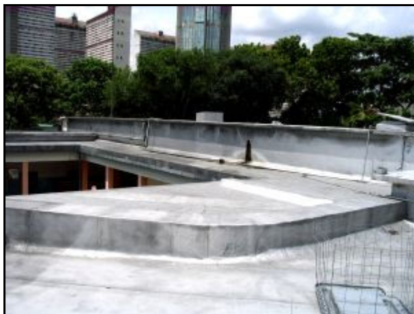
Imagen A.42. Planta Techo Norte-Este. Vista al Sur.
