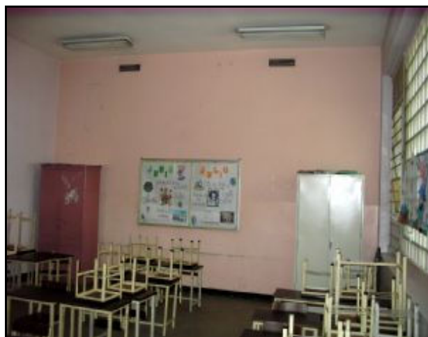
Imagen A.21. Salón de clase, planta baja sur, vista al Este
