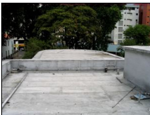
Imagen A.37. Volumen curvo, Planta Techo. Oeste. Vista al Norte.
