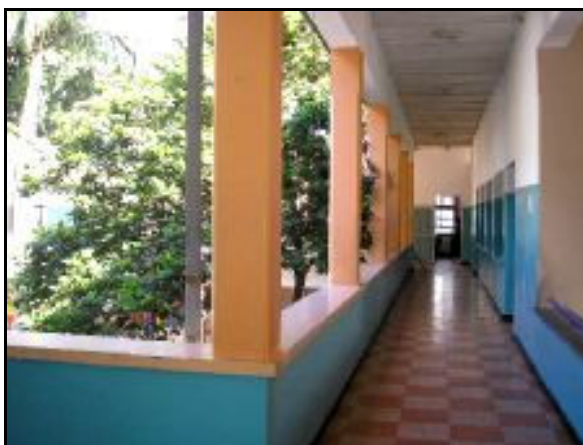
Imagen A.14. Vista del pasillo adjunto a la escalera central, se observa las vigas de acero en la planta alta, Patio América Sur-Norte.
