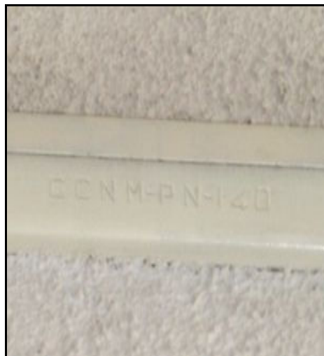
Imagen IV.4. Detalle del perfil IPN 14.
