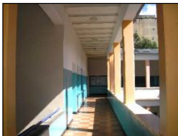
Imagen A.23. Pasillo transversal, planta alta Centro-Sur. Vista al Norte.
