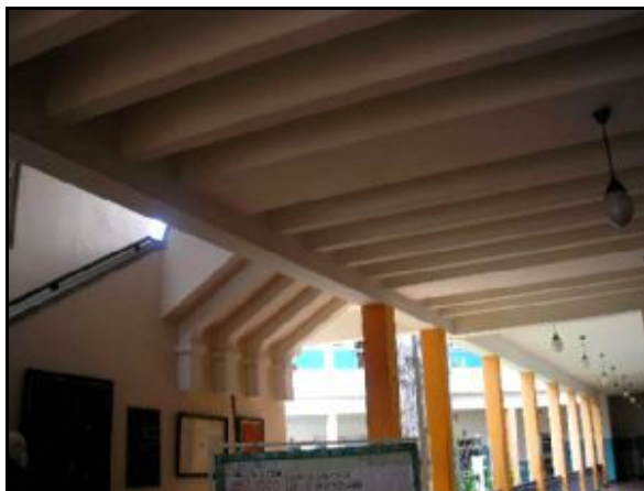
Imagen A.10. Entrada Principal. Se observa el detalle de la losa nervada, en el área de hall, Vista al Patio Venezuela.
