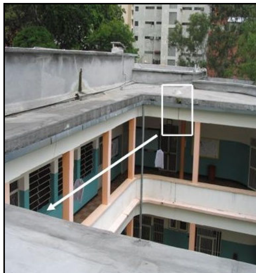
Imagen IV.10 Impermeabilización sobre Juntas Estructural.
