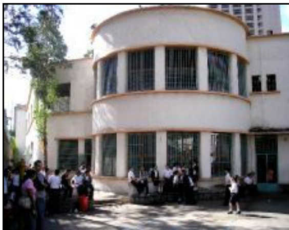
Imagen A.4. Fachada Centro-Norte. Volumen curvo. Vista al Sur.
