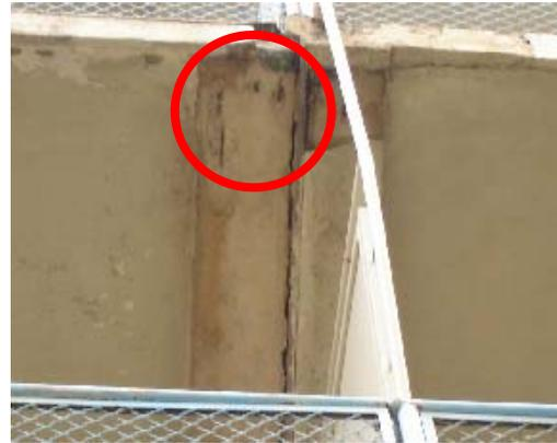
**Figura IV.4.29** – Foto Deterioro de Junta Externa en Balcón. Evidencia de Cabillas. Módulo III – Módulo VI. Piso 2.
