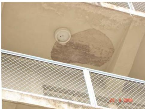
**Figura IV.4.25** – Foto Desprendimiento de Friso en Techo de Balcón Externo.
