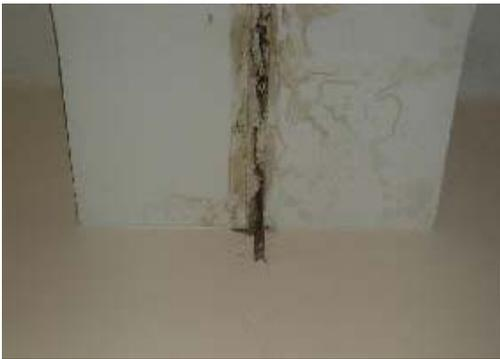
**Figura IV.4.26** – Foto Deterioro de Junta Interna en Techo. Módulo I – Módulo II. Piso 1.
