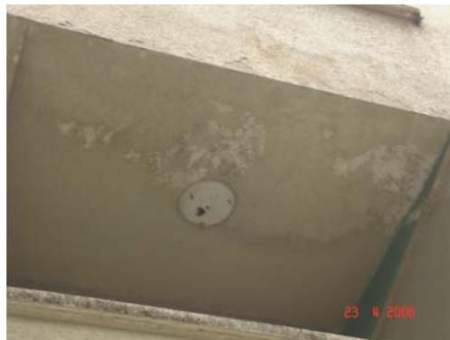
**Figura IV.4.24** – Foto Presencia de Humedad en Techo de Balcón Externo.
