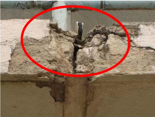
**Figura IV.4.28** – Foto Deterioro de Junta Externa en Balcón. Evidencia de Platina. Módulo V – Módulo VI. PB.
