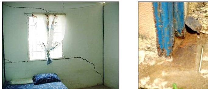
Figura V-13. Falla Muro y Corrosión de Base de Columnas
