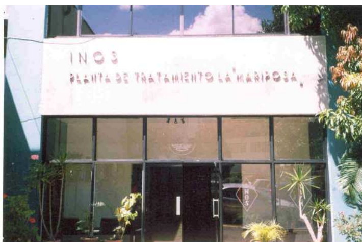
Foto 3.2. Planta de Tratamiento la Mariposa.
