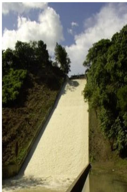
Figura 34. Foto del rápido en funcionamiento y pozo disipador cumpliendo su función. (Tomado de Orituco.com, [Consulta: 2007, Febrero, 03])
