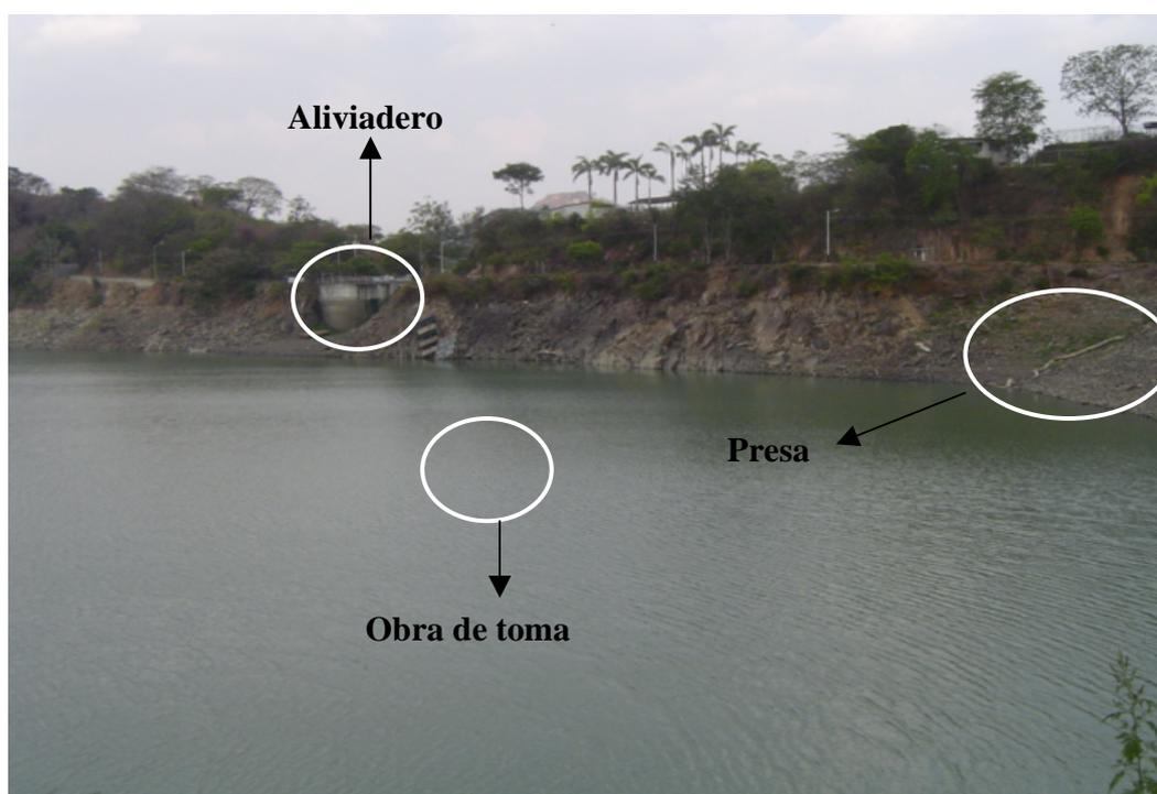
Figura 25. Configuración del sistema Aliviadero – Presa. (Fuente propia).
