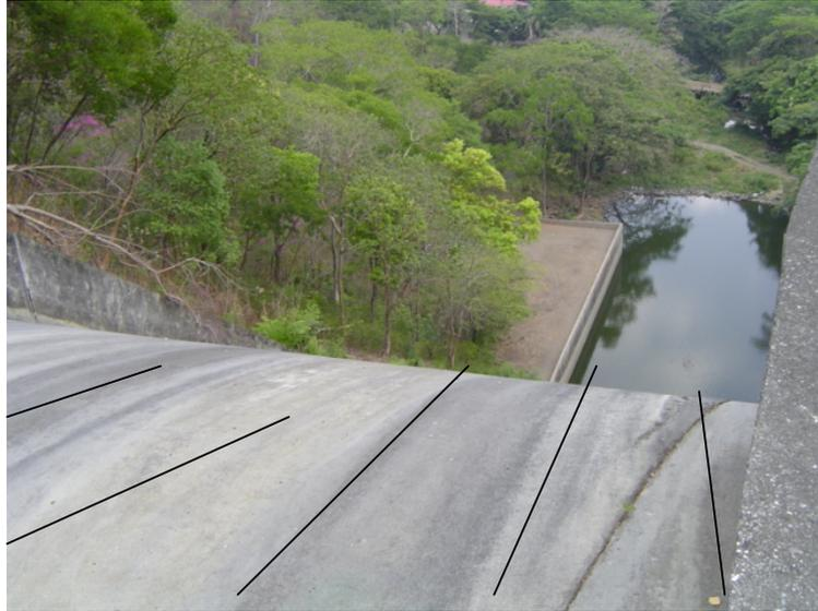
Figura 32. Vista aguas abajo de las compuertas, donde se observa el inicio del rápido de descarga y al fondo el pozo disipador. (Fuente propia).
