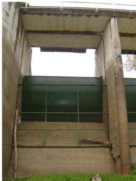
Figura 29. Detalle de las compuertas en la parte interna del embalse. (Fuente propia).
