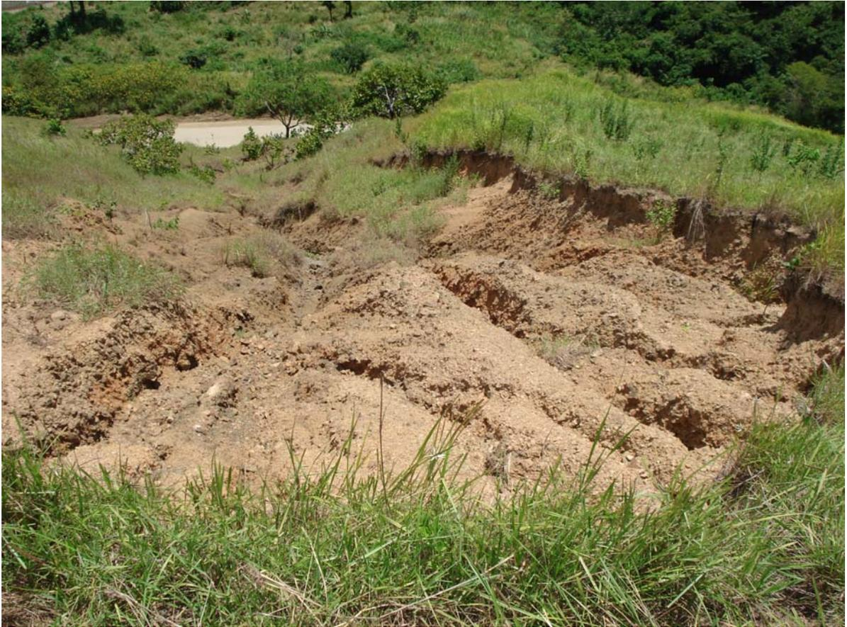
Figura 24. Vista aguas abajo de otra cárcava adyacente a la vía de acceso al embalse. Se observa en la parte superior de la foto la vía de acceso. En periodos de lluvia se supone que todos estos sedimentos bajan hasta la vialidad y bloquean el tránsito. (Fuente: Proyecto Río Orituco, Altagracia de Orituco).
