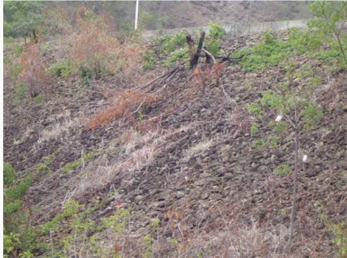
Figura 37. Detalle del enrocado aguas abajo de la presa y vegetación presente en la misma.
