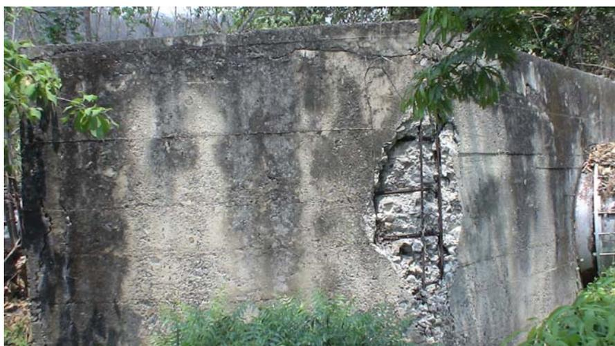
Figura 42. Concreto de soporte de tubería deteriorado. (Fuente propia).
