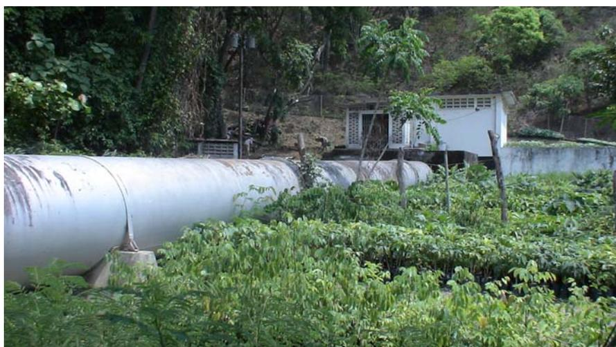
Figura 41. Tubería de aducción oxidada. (Fuente propia).
