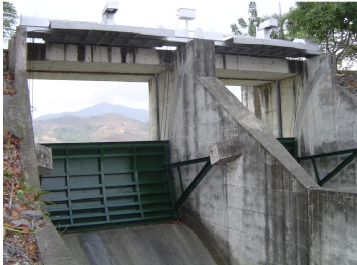
Fig. 26. Vista aguas arriba de las compuertas del aliviadero. (Fuente propia)
