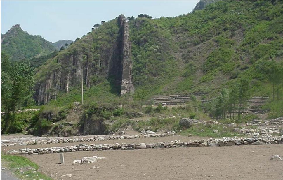
Figura 9. Control de la erosión en suelos fáciles de erosionar, mediante pequeños muros de roca, que al retener la humedad, facilitan el desarrollo de plantas autóctonas. Al fondo en la colina, se aprecian terraceos hechos para reforestar. (Tomado de: “Sedimentación en embalses”. Gaspar, J., pág. 66)
