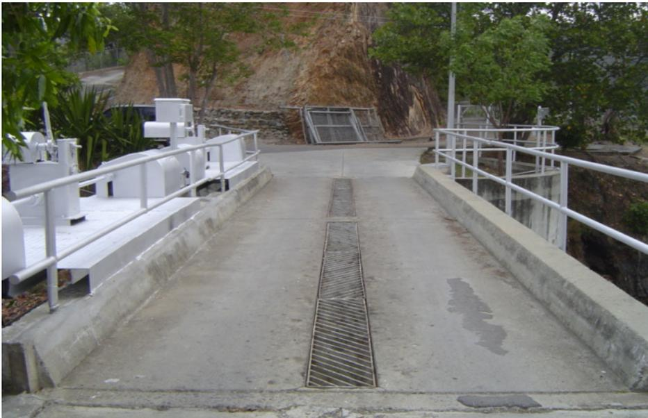
Figura 27. Detalle de la maquinaria controladora de las compuertas y rampa de acceso al embalse Guanapito. (Fuente propia).
