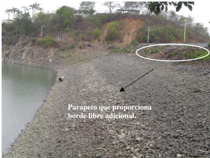
Figura 40. Vista lateral del talud aguas arriba de la presa. (Fuente propia).
