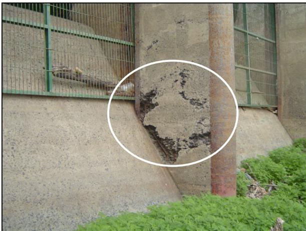
Figura 30. Acercamiento a una de las fallas en las zonas aledañas a las compuertas. Llama la atención que este defecto de vaciado no fue corregido en su momento. (Fuente propia).
