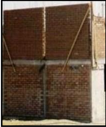
Figura II.1. Ejemplo de Mampostería Confinada. Fuente: Propia.
