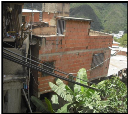
Figura II.5. Ejemplo de Mampostería Sin Confinar. Fuente: Propia.
