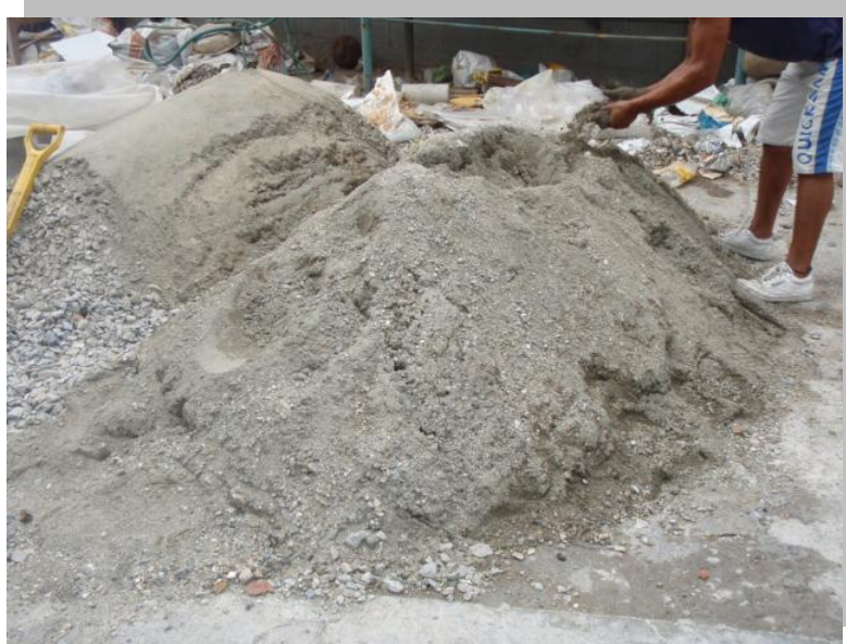
Imagen 4. Agregados colocados en área de trabajo.
