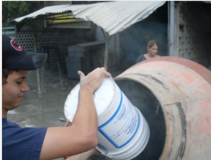
Foto # III.11 Adición del cemento a la mezcladora.
