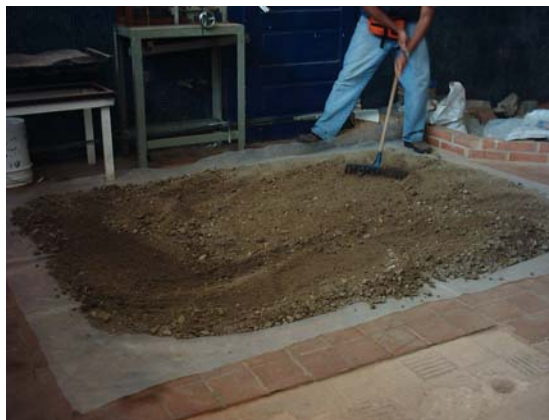
Foto 3.4. Preparación del suelo.
