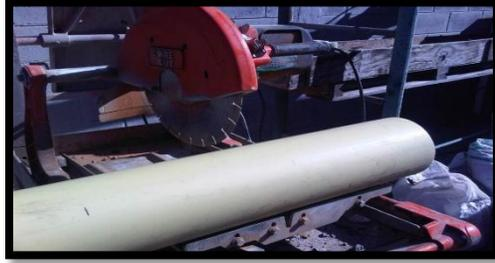
Figura IV.9: Cortes de tubo PVC con tronzadora.
