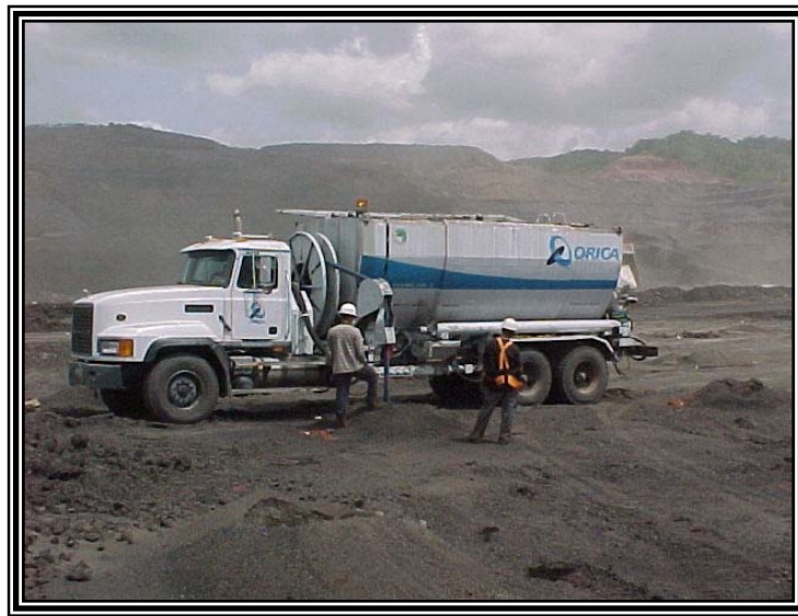
Figura 3.2. Carga de Barrenos con el camión de explosivos (Camaleón).
