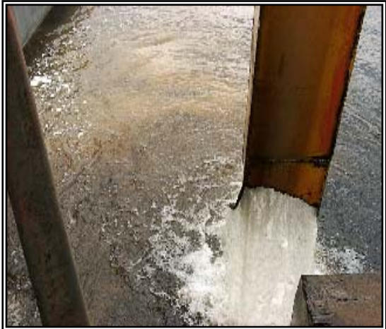
Figura 2.e y f: Sistemas de descarga de colas en balsas en el río Caroní
