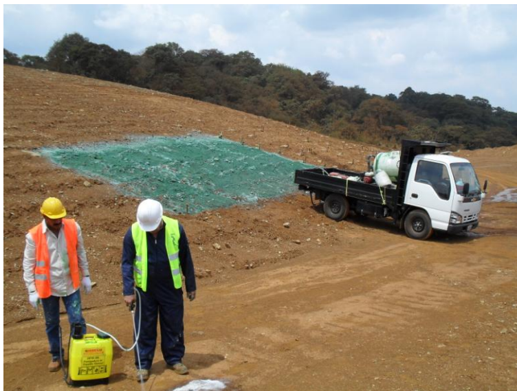
Fig. 6 Reforestación de Talud
