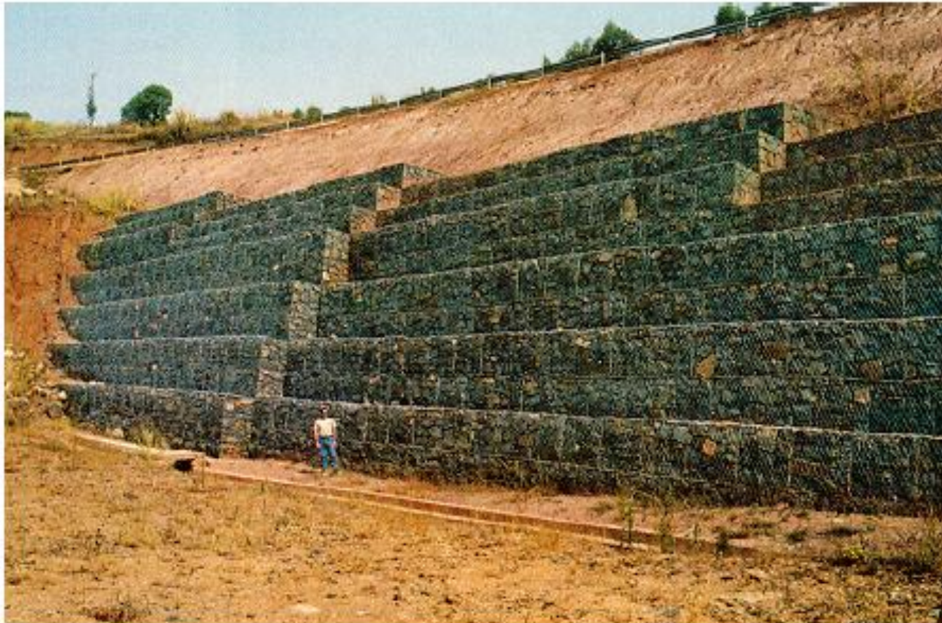
Figura 10.40.-Muro de contención en la carretera Bafoussan-Bamenda (Camerin)
