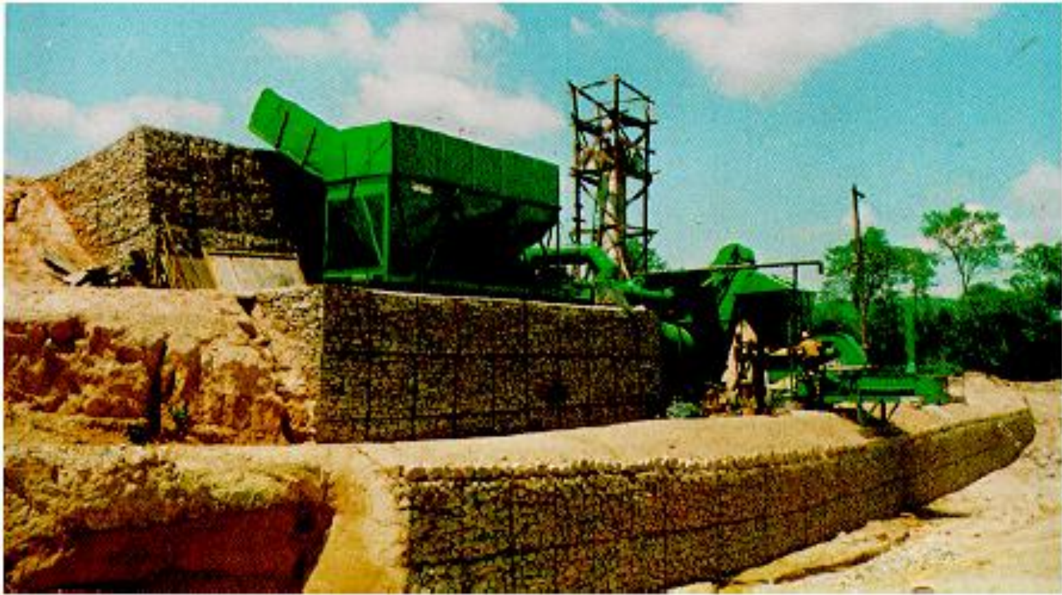
Figura 10.45.- Estructuras construidas en tres niveles para sostener una machadora en Jundial (Brasil - Sao Paulo)
