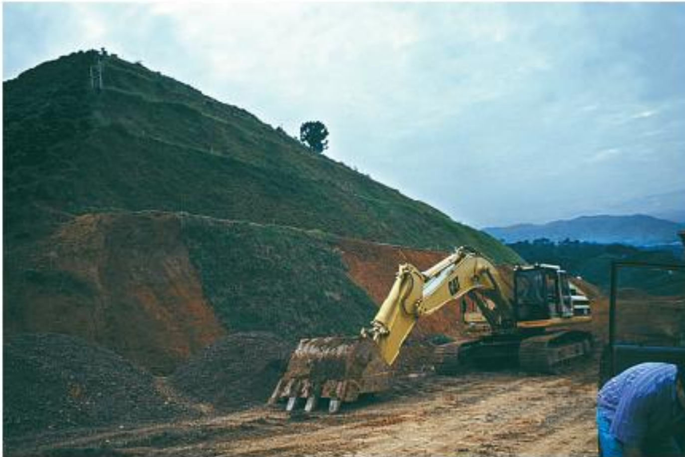
FOTOGRAFÍA 10.2 Talud conformado y vegetalizado.
